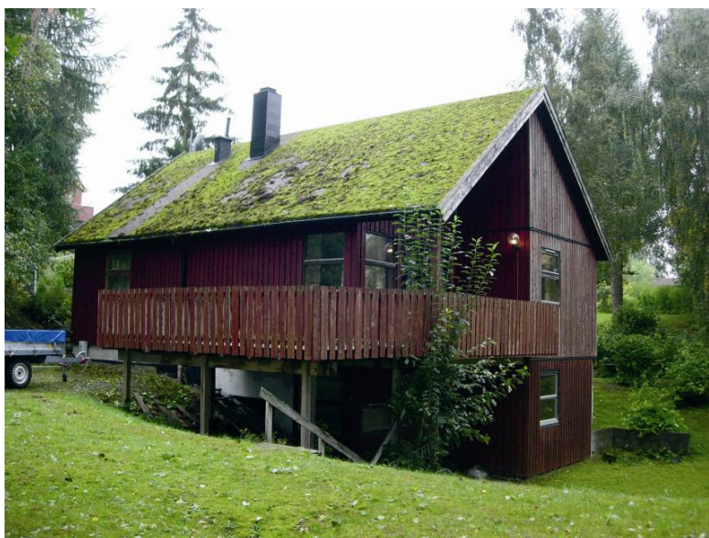
Figur 4.5.5 Mildere klima og mer nedbør vil gi økt begroing og medfølgende økt behov for vedlikehold av bygninger. Foto: Tore Kvande, SINTEF Byggforsk
