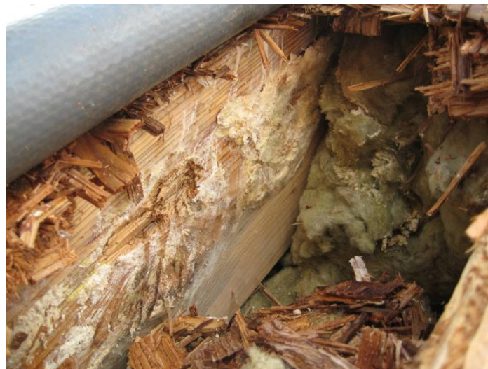
Figur 4.2.1 I et mildt og fuktig klima kan det over tid oppstå råteskader i en bygningskonstruksjon. Her fra en takkonstruksjon. Et varmere og våtere klima vil øke risikoen for råteskader. Foto: Anders-Johan Almås
