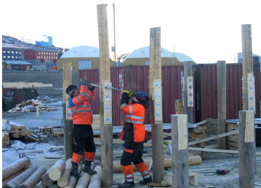
Figur 4.9.4 Pæling og spunting (skjøting av stokker) i forbindelse med nybygging, Longyearbyen, Svalbard. Foto: C.F. Øyen
