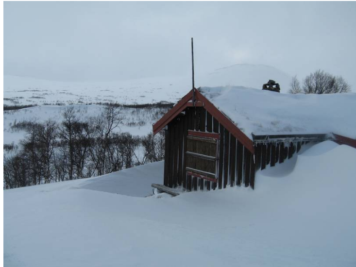
Figur 4.4.4 Plassering av bygninger er av stor betydning for hvordan snøen legger seg på taket. Her et bilde fra en hytte i Hessdalen, Sør-Trøndelag, der mesteparten av snøen på taket har blåst av og det danner seg fonner rundt hytta og opp langs fasaden på baksiden. Foto: Cecilie Øyen
