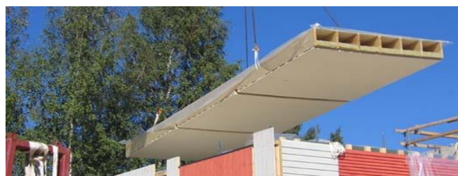
Figur 3.5 Montering av Ripa floor element (hentet fra https://goo.gl/QBE43S )
