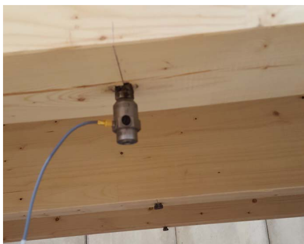
Figur A.1.2 Plassering av akselerometer på bjelke A, bjelke B i midten og bjelke C lengst unna.
