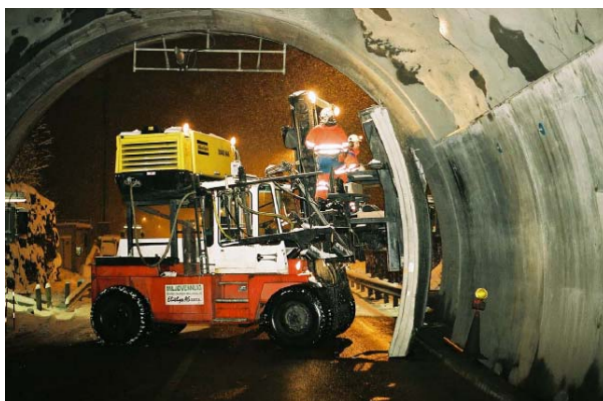
Figur 3.12: Illustrasjonsbilde av betonghvelv under montering. (foto: Vegdirektoratet)
