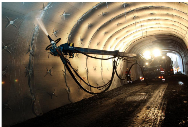
Figur 3.11: Illustrasjonsbilde av PE-skum som blir dekket med sprøytebetong (foto: Midt-norsk betongsprøyting AS).
