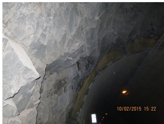
Figur 4.8: Et parti i tunnelen uten hvelvkonstruksjon. her er berget sikret med bolter og noe nett (Vie og Ødegaard 2015)
