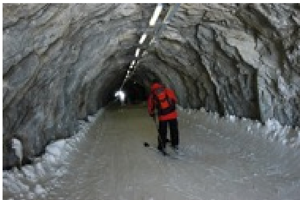
Figur 10.10: Illustrasjonsbilde skitunnel med råsprenget berg ( Hohstock Skitunnel 3112müM 2008 )
