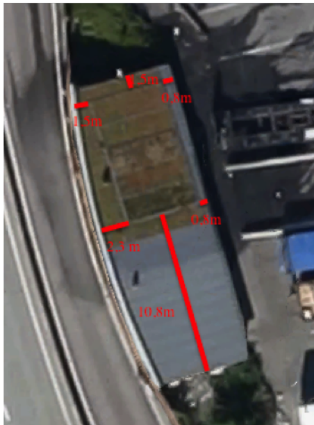
Figur 10: Taket sett ovenfra.
