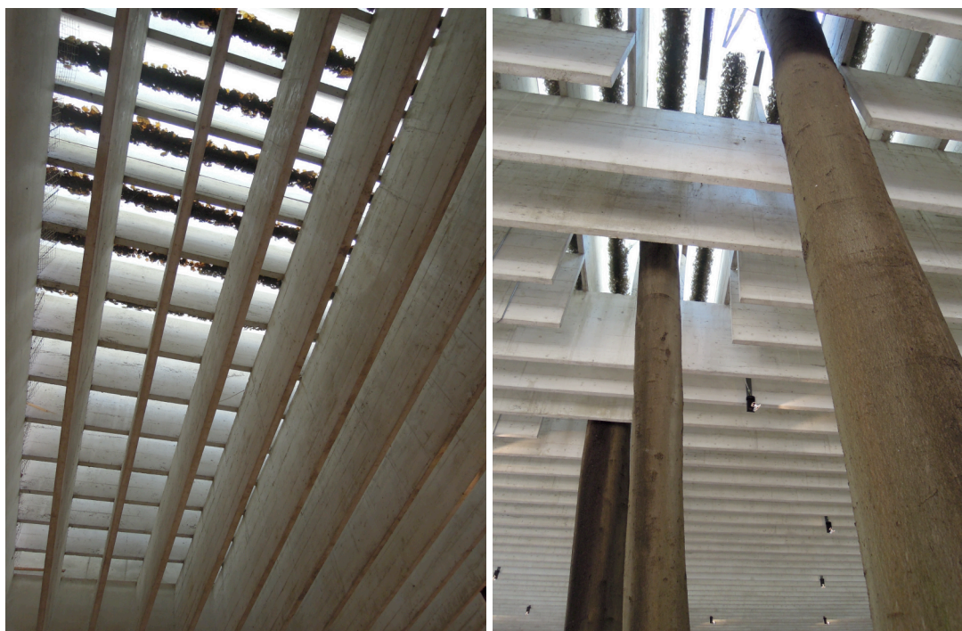
Figur 16: Betongdragerne i takkonstruksjonen i den Nordiske Paviljongen i Venezia
