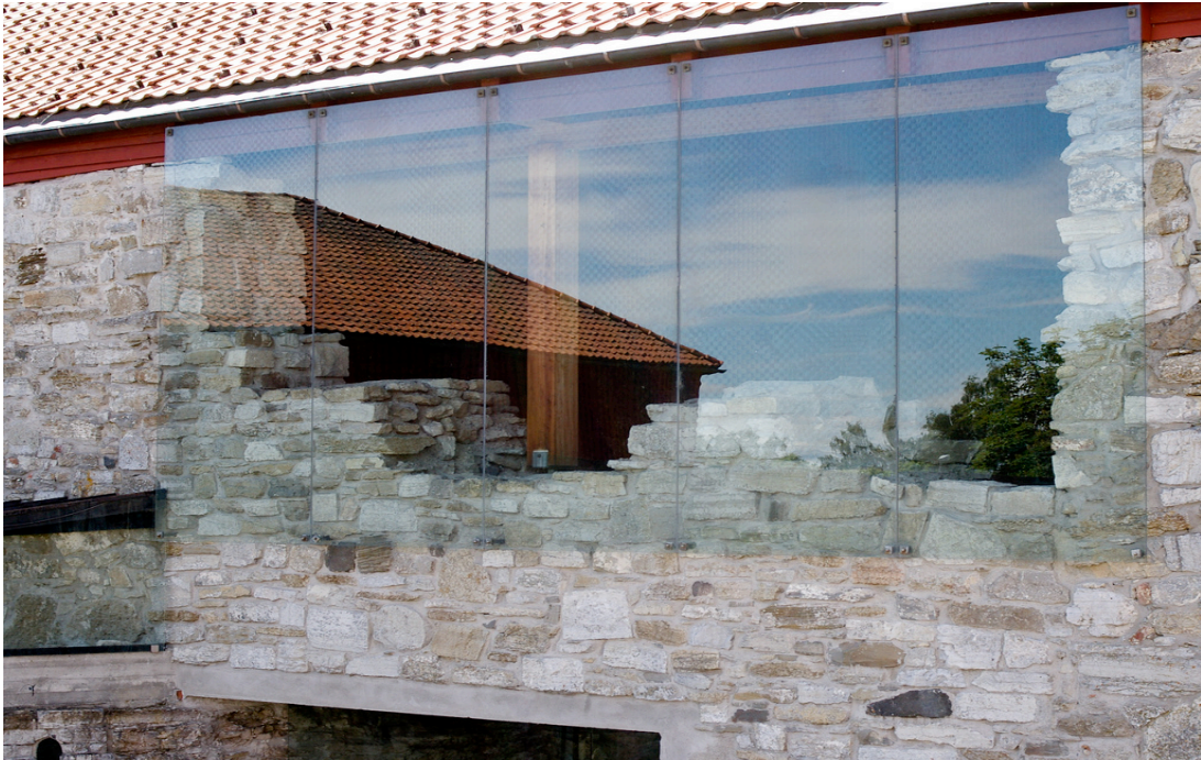
Figur 9: Detalj: Storhamarlåven og glassbruk
