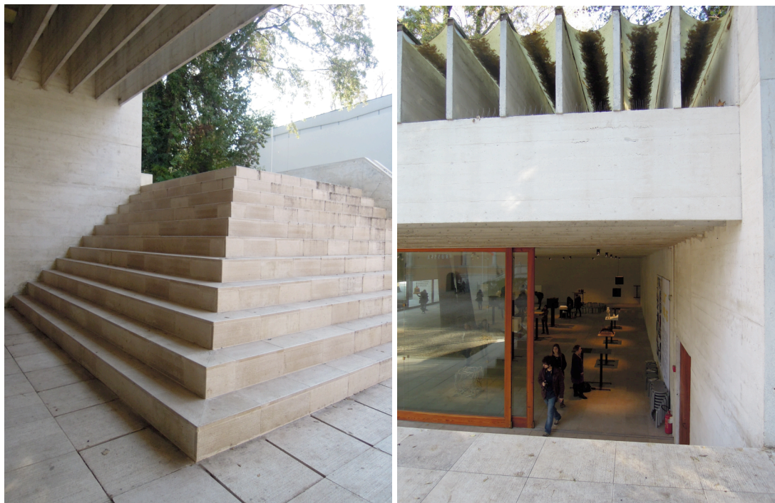
Figur 20: Venezia-paviljongens utvendige trapp / på toppen av trappen, på høye med taket
