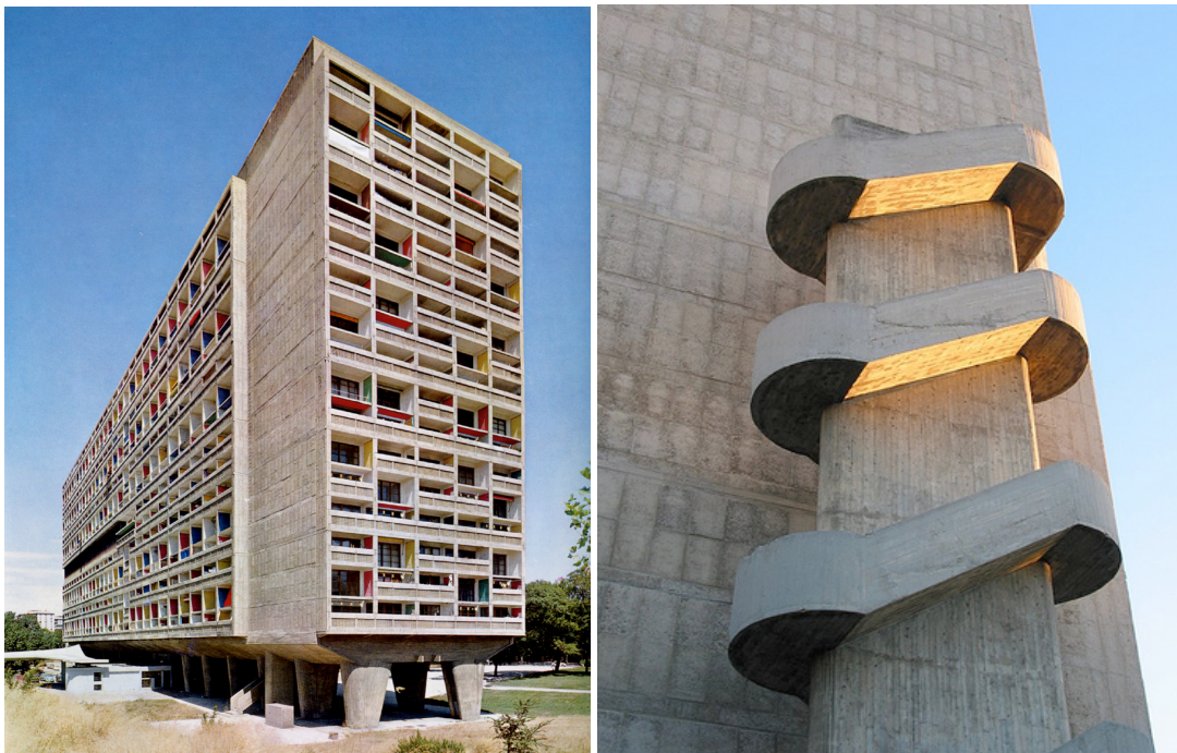
Figur 15: Unité d'Habitation, Marseille / detaljbilde eksteriør
