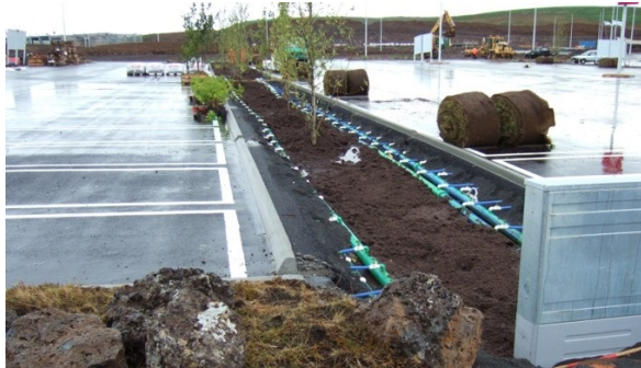
(a) Bygging av swale.
