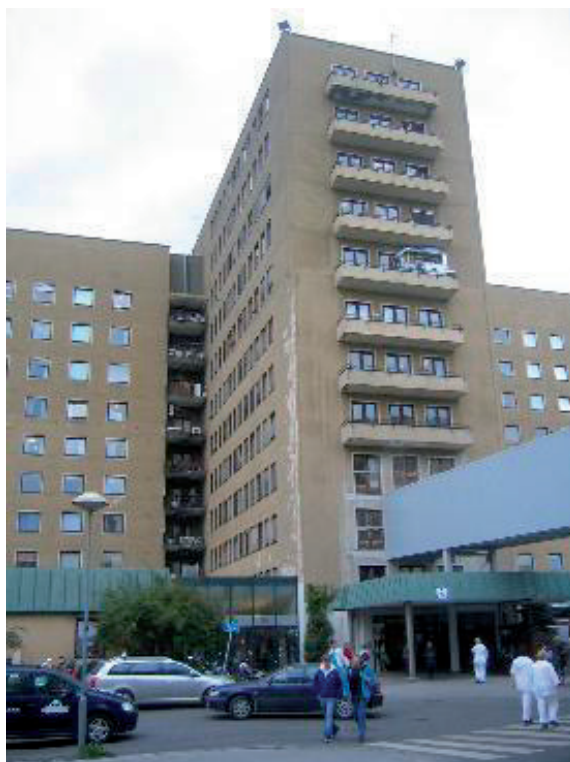
Høyblokka på det gamle sykehuset. Denne ble revet i forbindelse med nybyggingen.
