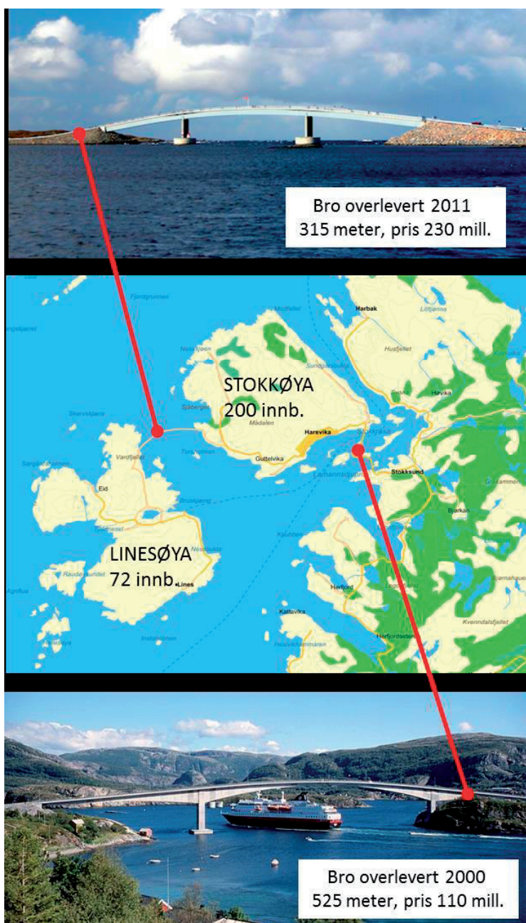
Figur 3.4 Fastlandsforbindelsen til Stokkøya og Linesøya i Sør-Trøndelag
