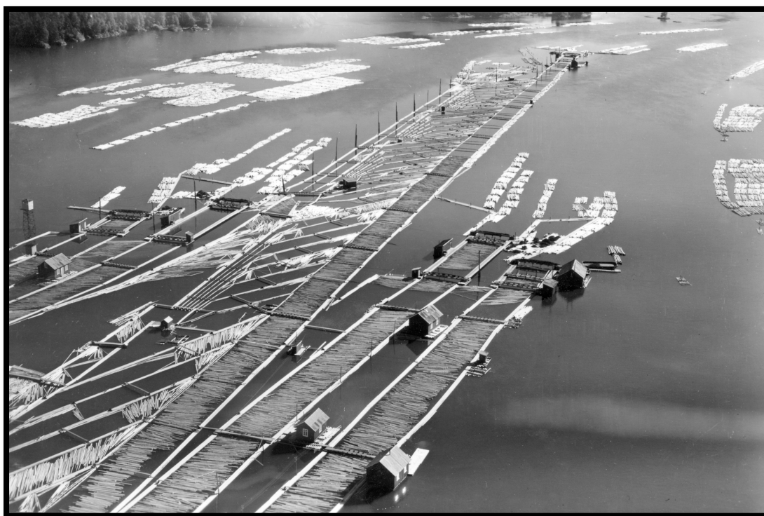
Bilde: Til høyre i bildet ser vi a-avdelingen, og to mosemaskiner. Den ytterste maskinen, lille a, moser sammen tømmer, mens store a fortsatt fyller inn stokker i maskinen. Nederst i bildet kan vi skimte c-avdelingen, også kalt Etiopia. (Foto: Norsk Skogmuseum)
