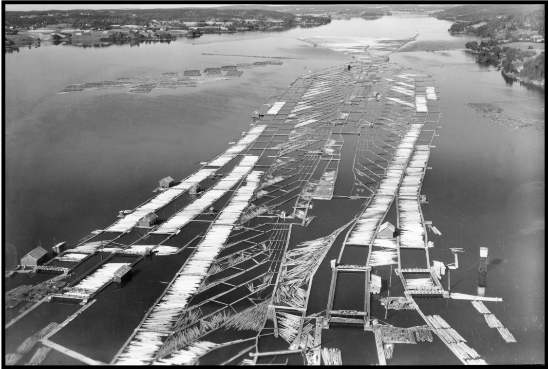
Bilde: Oversiktsbilde over Glennetangen lense. Øverst ser vi storlensa, og på hver side lenken som sørget for at tømmeret samlet seg ved inntaket til lensa. (Foto: Norsk skogmuseum)
