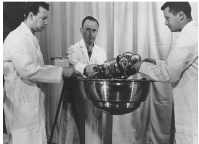
Bilde 2: Fallsjerm blir lagt til i kapselen. 143
