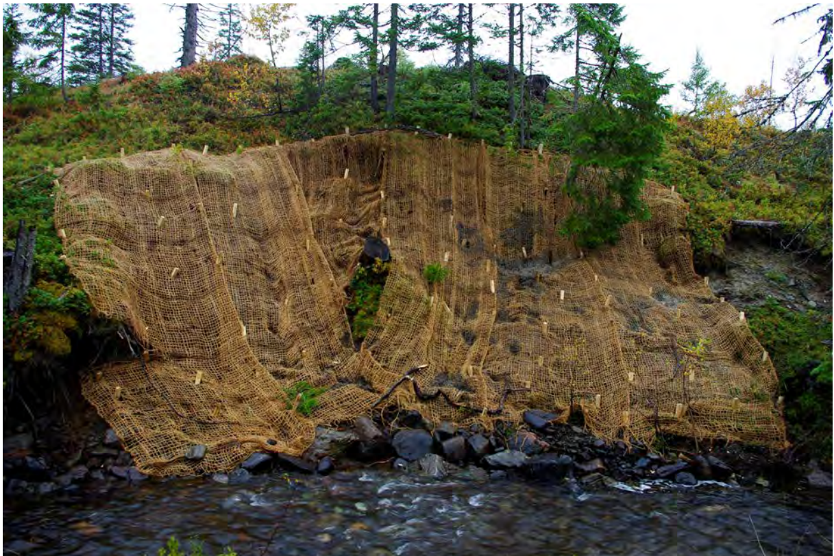
Figur 15. Elvemæl med slaggvelt etter oppretting og montering av erosjonsnett. Foto: Ragnhild Berge, NTNU Vitenskapsmuseet
