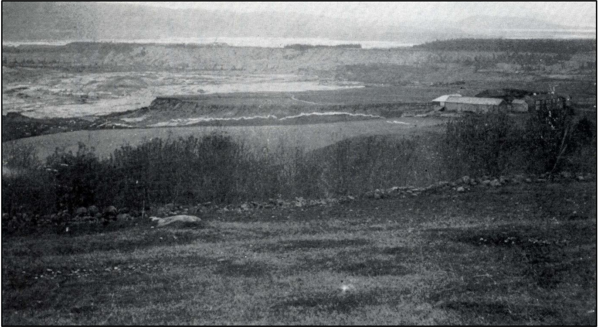
Figur 10: Fotografi fra 1893 som viser ødeleggelsene etter Verdalsraset. Gården ute på raskanten til høyre i bildet er Gjermstad Øvre, som siden ble flyttet. Senere på året raste også den framskutte sletten midt i bildet ut. På den andre siden av rasgropa, midt i bildet, ligger Mo. Den oversvømte dalbunnen vises bakerst i bildet. Bildet er tatt mot SV. Etter Walberg 1993b:182.
