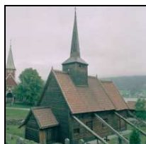
Figur 168. Rødven Stavkirke med staver og binding. Kirken er antatt oppført rundt 1200-tallet.
