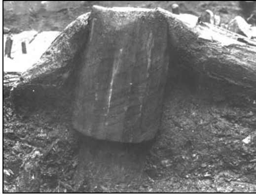
Figur 172. Fundamentstabbe fra Søndre gate, Trondheim. Datert til 1100- tallet e.Kr. Stabben har fungert som fundament under en laftet bygning. Levningen måler mindre enn 1077 (ca 35 cm i diameter), men har samme bearbejdede tverrsnitt som 1077 og 1145. Fra Riksantikvarens arkiv, avdeling Trondheim.
