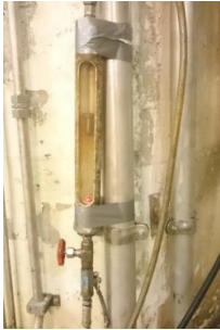
FIGUR 6-7: Rotameter benyttet for volumstrømsmåling av vannet som strømmer forbi termometeret i den termodynamiske proben i innløpet
