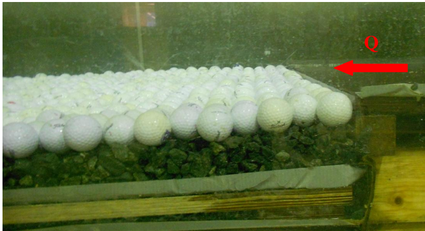
Overgang mellom renne og plastring
