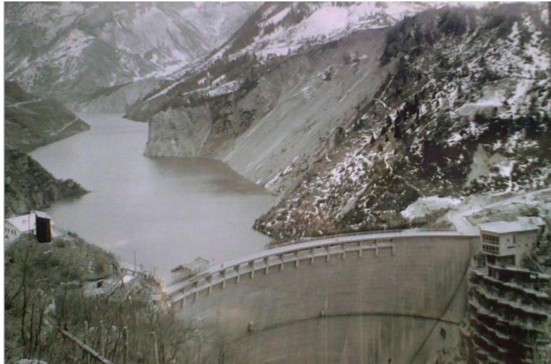
Figur 2.3 – En kan tydelig se den utløste fjellsiden i Vajont Dam i Italia i 1963 (Midttømme, 2013).
