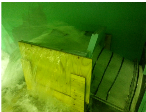
Figur 6.11 Utløp flomtunnel ved Q_{DIM} utan justert nedstraums vasstand
