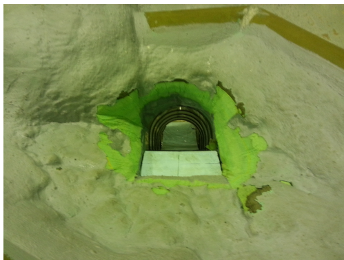
Figur 6.10 Samlekanal og innløp sjakt etter utbetring
