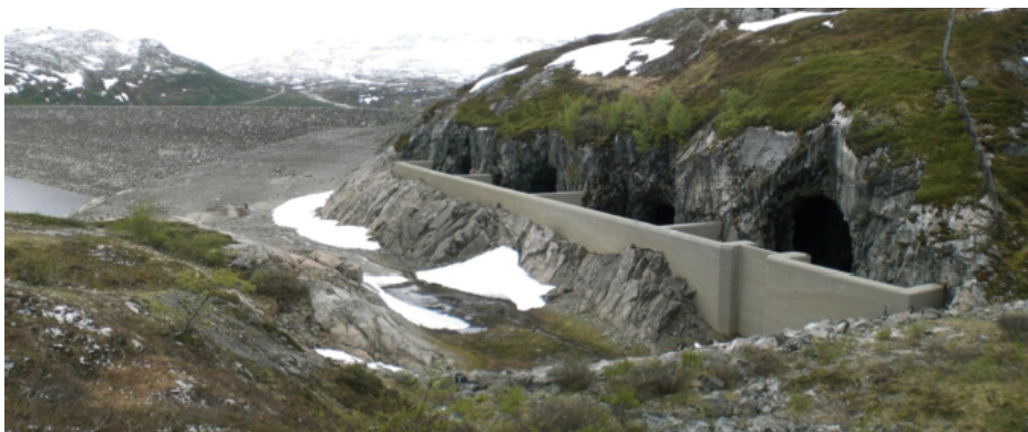
Figur 4.14 Overløpsterskel med greintunnelar. Sysendammen i bakgrunnen (Birkeland, 2008)
