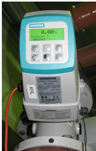
FIGUR 4.6 VANNFØRINGSMÅLER, TYPE MAG 5000 (SIEMENS, 2005)
