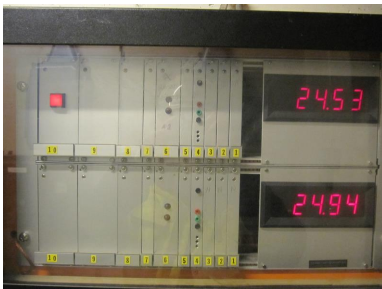
Figur 15 Instrumentkasse for måling av vannivå i luftputekammeret
