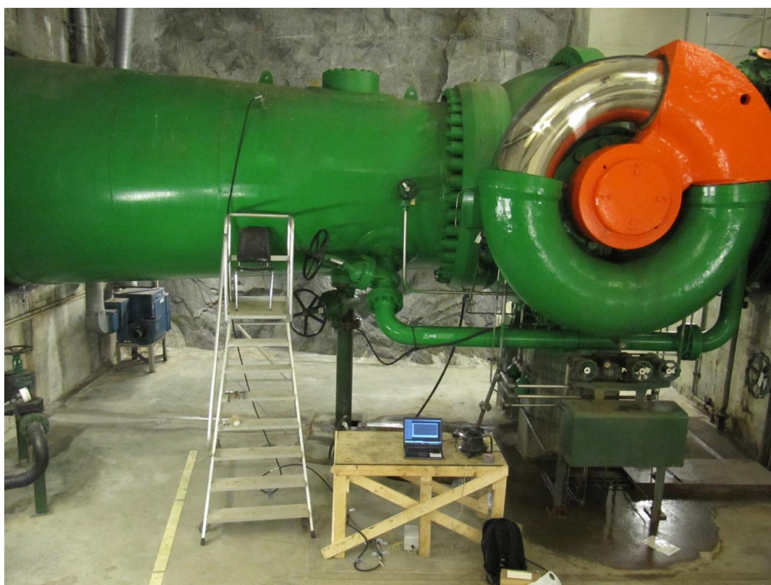
Figur 13 Montasje for trykkmålinger i tilløpstunnelen på Oksla kraftverk
