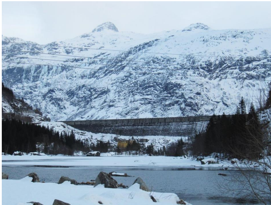
Figur 10 Ringedalsdammen sett fra nedstrøms side (Foto: mars 2013)
