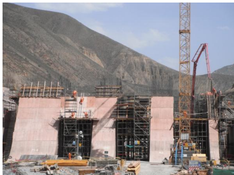
Dam og lukeseksjonen den 30. november 2012
