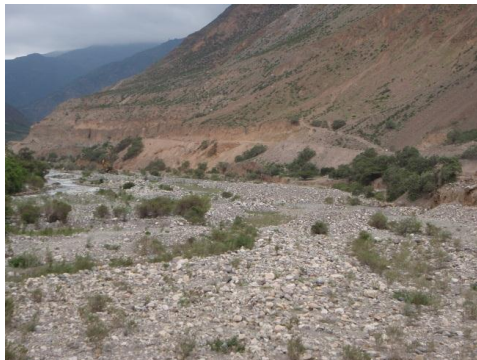
Damstedet 19. januar 2011. Sett fra nedstrøms side.
