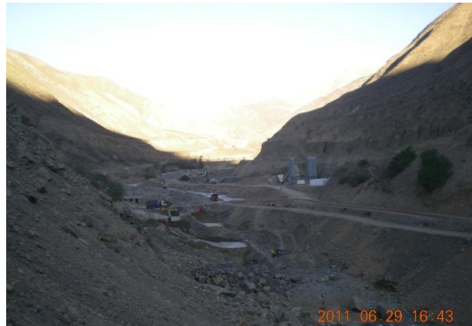
Damsted og betongbladeanlegg 29. juni 2011
