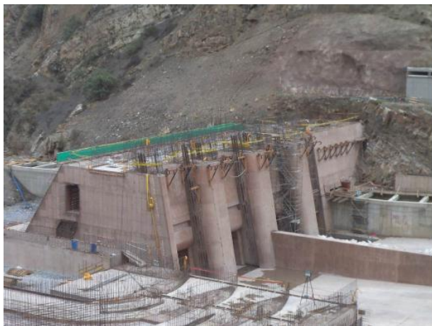
Dam- og lukeseksjonen den 8. desember 2012.
