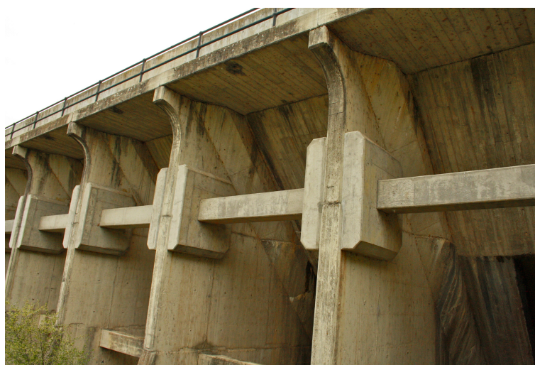
Figur 6.4: Utførelse av kapiteler ved nye avstivningsbjelker i Stony Gorge Dam.
