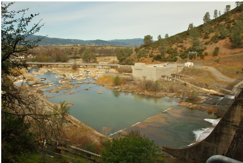
Figur 3.3: Energidreperbasseng og kraftverk rett nedstrøms dammen sett fra venstre vederlag.
