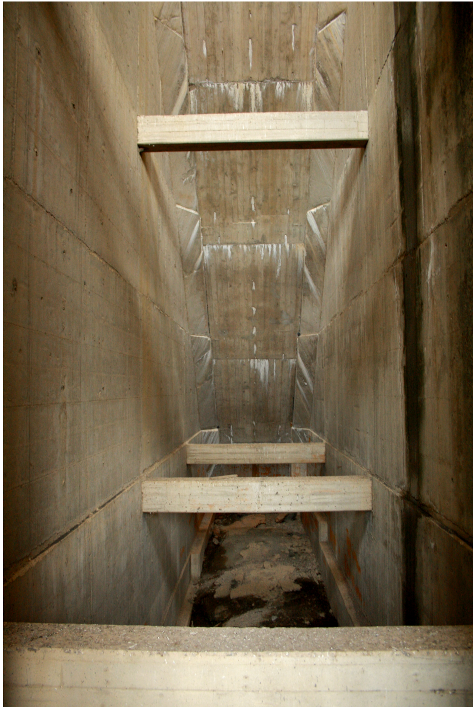
Figur 3.6: Typisk platefelt med originale avstivningsbjelker.
