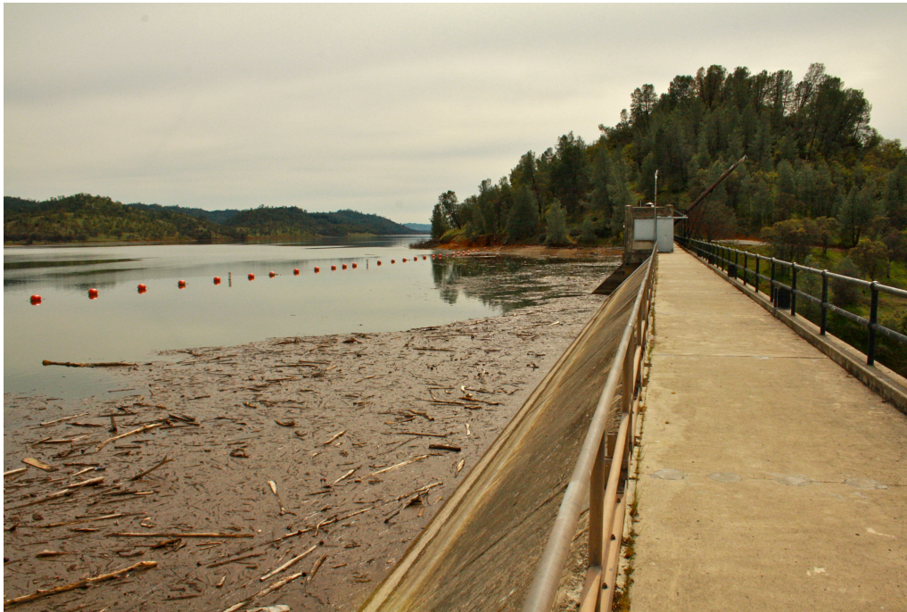
Figur 3.4: Damkrone sett fra høyre vederlag.
