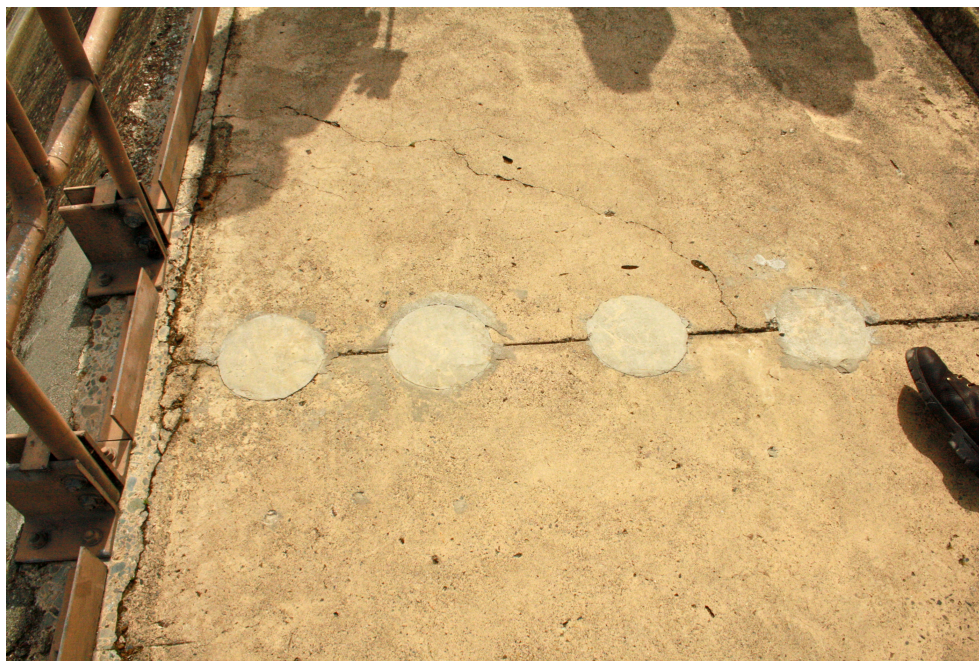
Figur 3.13: Øvre del av pilarene forsterket ved dybber.
