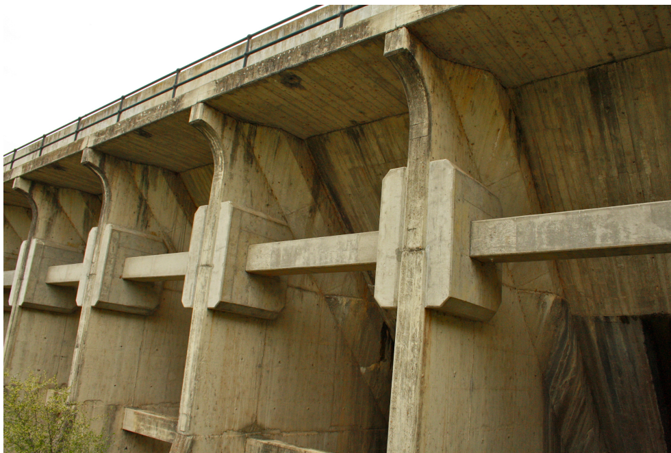
Figur 3.11: Utførelse av nye avstivningsbjelker i pilarens øvre del.
