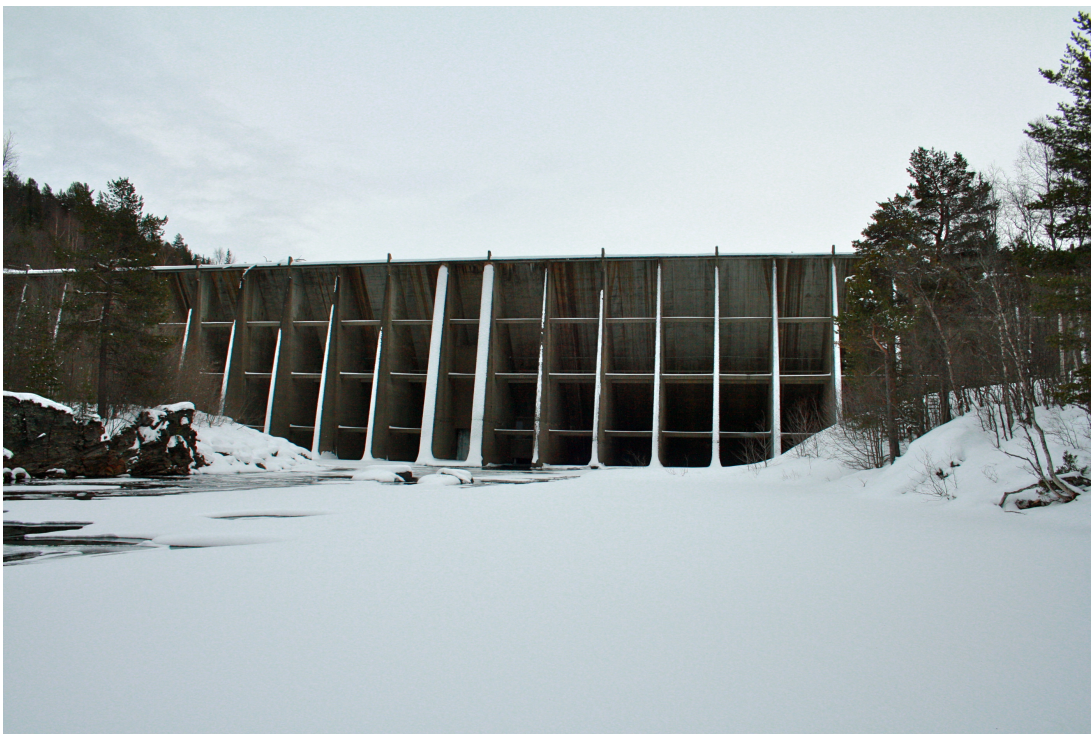
Figur C.11: Storfosdammen sett fra nedstrøms side.
