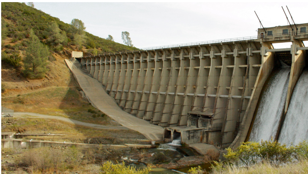
Figur 3.8: Erosjonssikring under overløpsseksjon.
