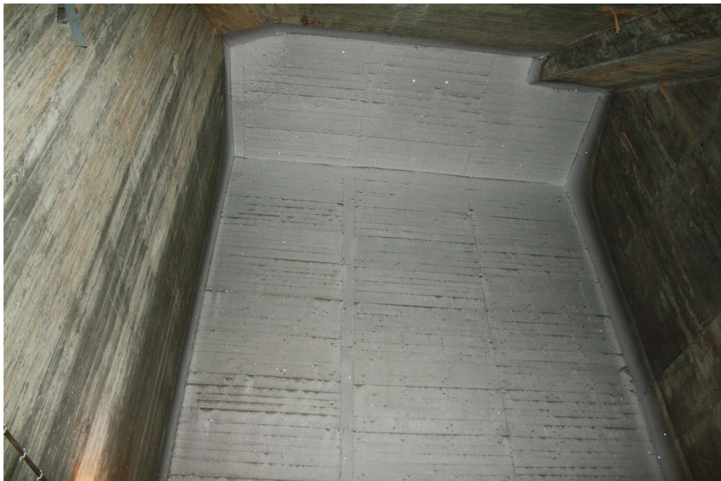
Figur C.6: Isolasjonsvegg i dam Håen.
