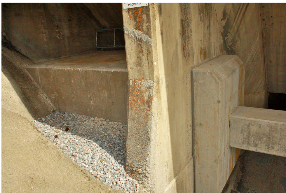
Figur 3.12: Overgang ved høyre vederlag mellom fundament og avstivningsbjelke i pilarens øvre del.
