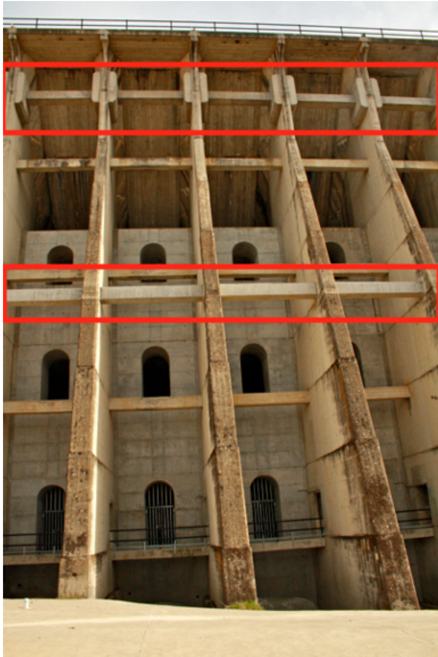
Figur 3.9: Oversiktsbilde over utført oppgradering. Nye avstivningsbjelker er markert.
