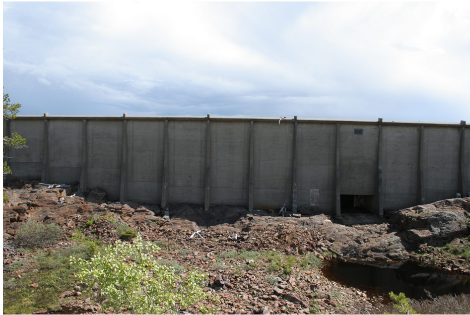
Figur C.1: Dam Håen sett fra nedstrøms side.*
