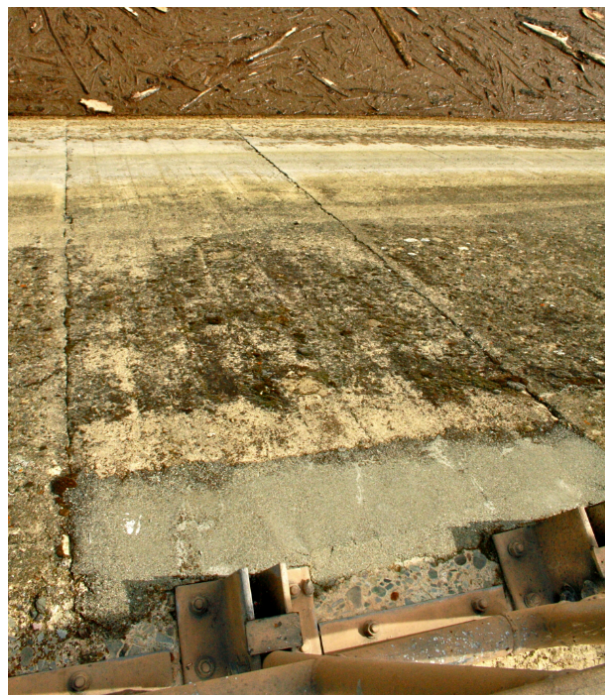
Figur 3.5: Opplagring av plater på pilar, sett fra damkrone.
