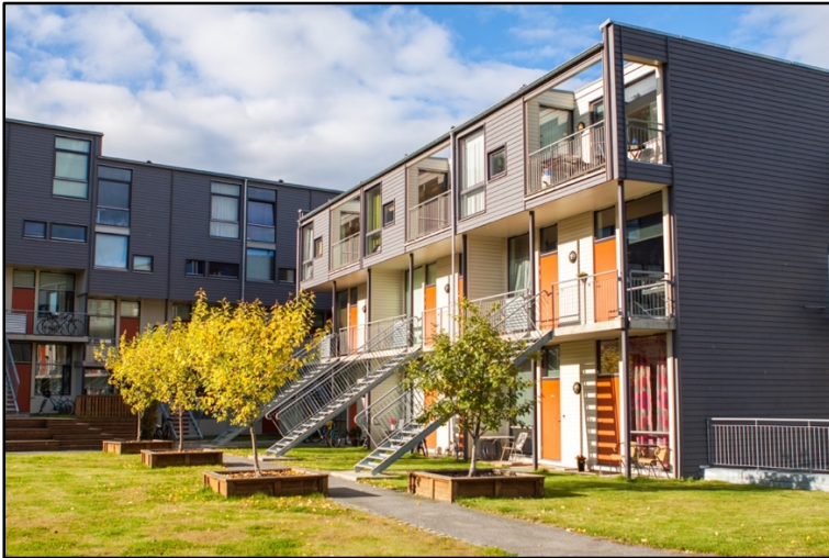
Bilde 5: Fasade blokk C med blokk D i bakgrunnen (Ilsvika Garden, 2016)
