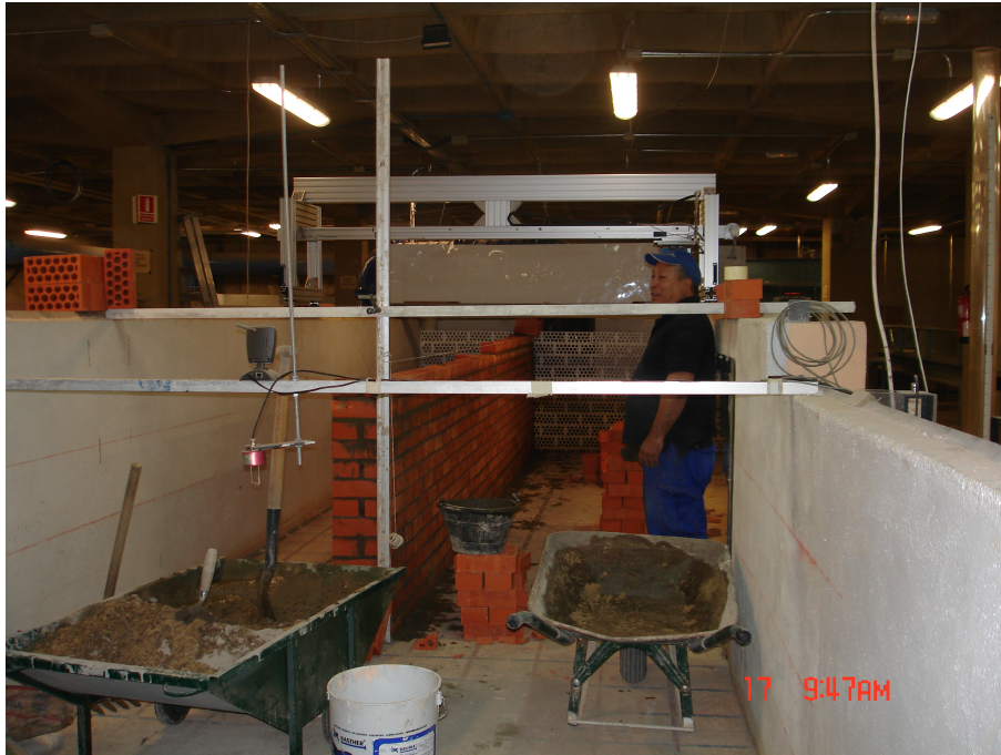
Figur 3.6: Bygging av kanal
