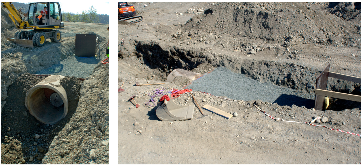
Figur 7.10: Nedgravd rør klar for trekkeforsøk i felt
