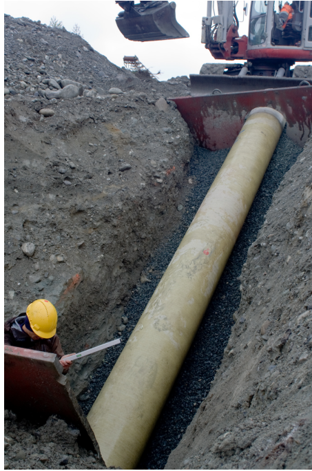
Figur 7.14: Legging av rør i bratt terreng
