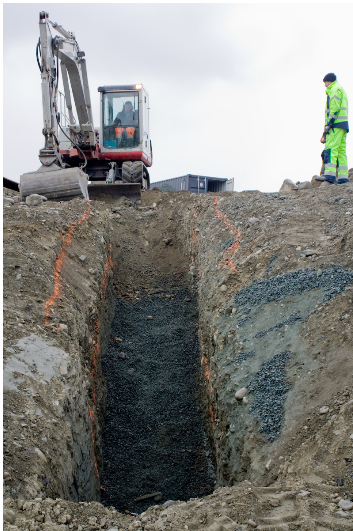
Figur 4.4: Utgraving av grøft i bratt terreng
