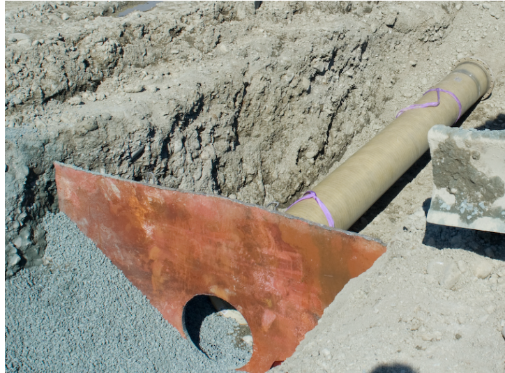
Figur 7.8: Stålplate med utsparing installert i grøft
