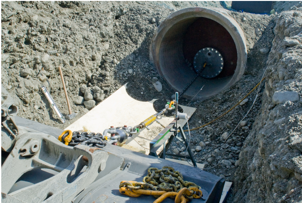
Figur 7.11: Forsøksutstyr oppmontert for friksjonsforsøk
