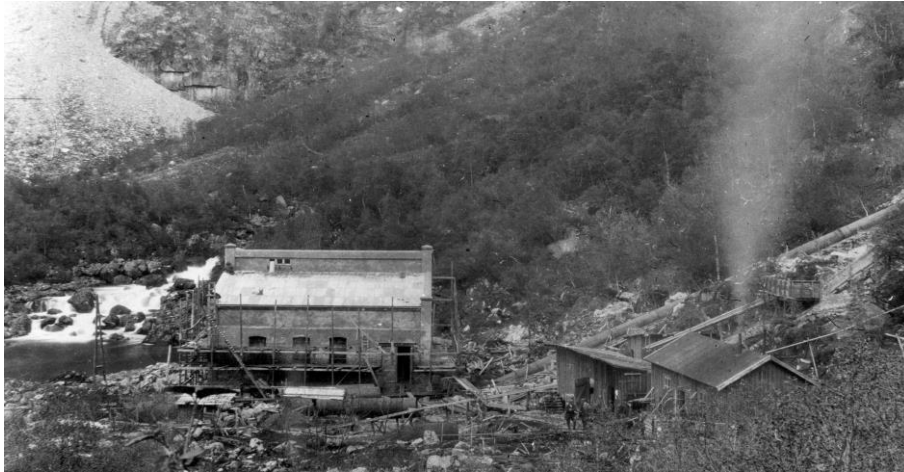
Figur 10. Dalafoss provisoriske kraftverk under oppføring. Foto: NTM.
