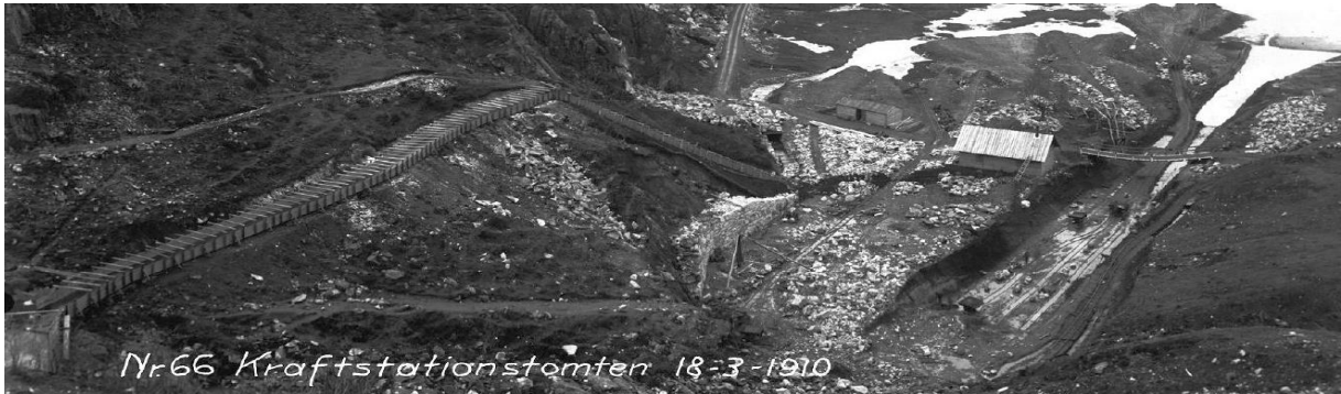
Figur 7. Frøland provisoriske kraftverk står inntil avløpskanalen. Foto: Samnanger historielag.
