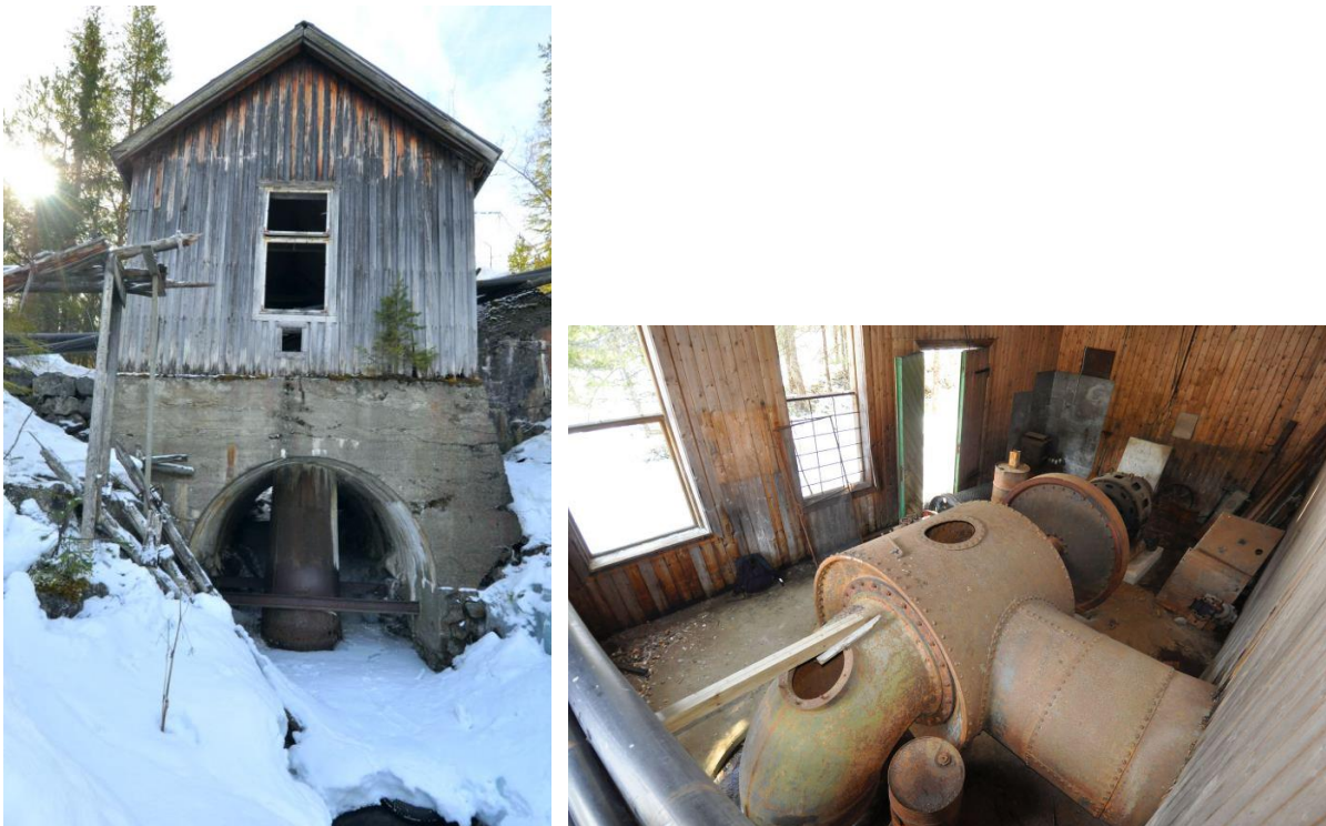
Figur 25. Faslefoss provisoriske kraftverk. Foto: Tatt 1. april 2015 av Terje Garcia de Presno (TGdP).
