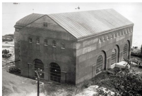
Figur 12. Bjølvo kraftverk. Foto: NVIM
