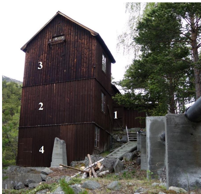
Figur 29. Aura provisoriske kraftverk i dag, Maskinhallen (1), Apparatrom (2), loft. (3) og kjeller (4). Foto: TGdP.
