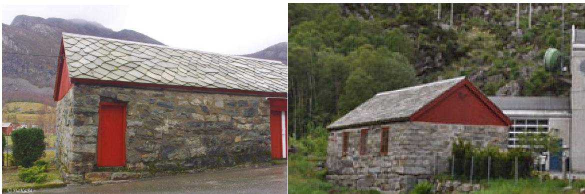
Figur 5. Rønli provisoriske kraftverk. Foto: sandalsand.net og NVE
