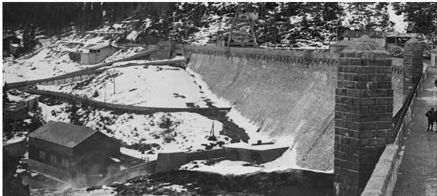
Figur 15. Anleggskraftverket ved Tunhovddammen omkring 1920. Foto: Ivar Aasen. Eier: NVE.
