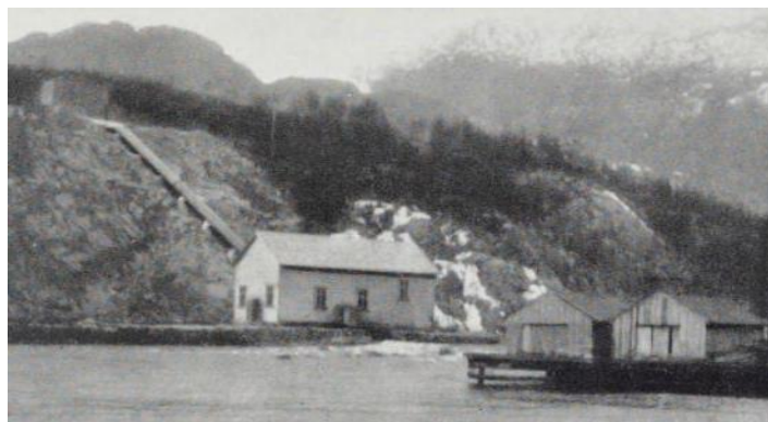
Figur 20. Oltesvik provisoriske kraftverket ca. 1918. Foto: Lyse
