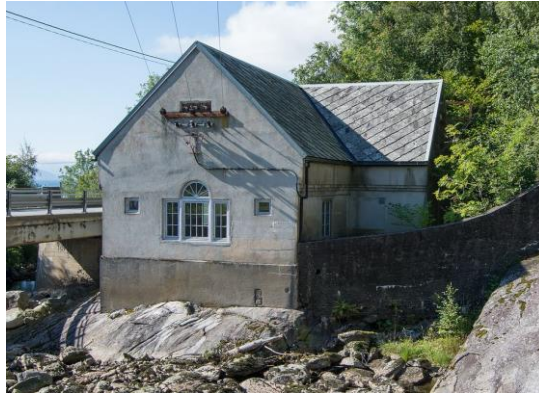
Figur 13. Ytre Ålvik provisoriske kraftverk. Foto: NVIM.
