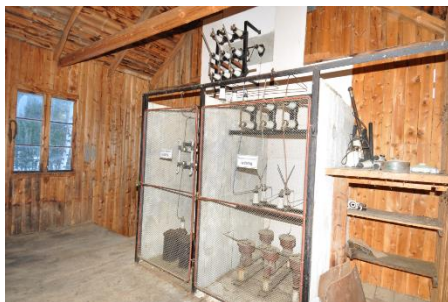
Figur 33. Cellene til bryterne på loftet. Foto: TGdP.
