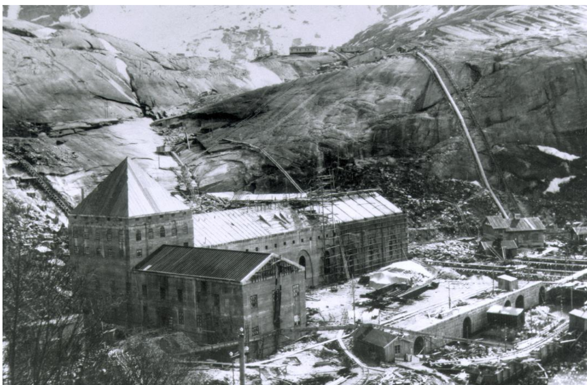
Figur 11. Glomfjord kraftverk fremst og Fykan provisoriske med en hvit rørgate. Foto Nordlandsmuseet.
