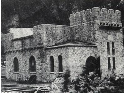
Figur 22. Tyin provisoriske kraftverk. Foto: NRK.
