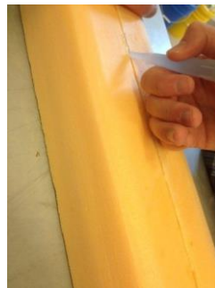
Figur 3.8.3: Fuging av skøyter.
