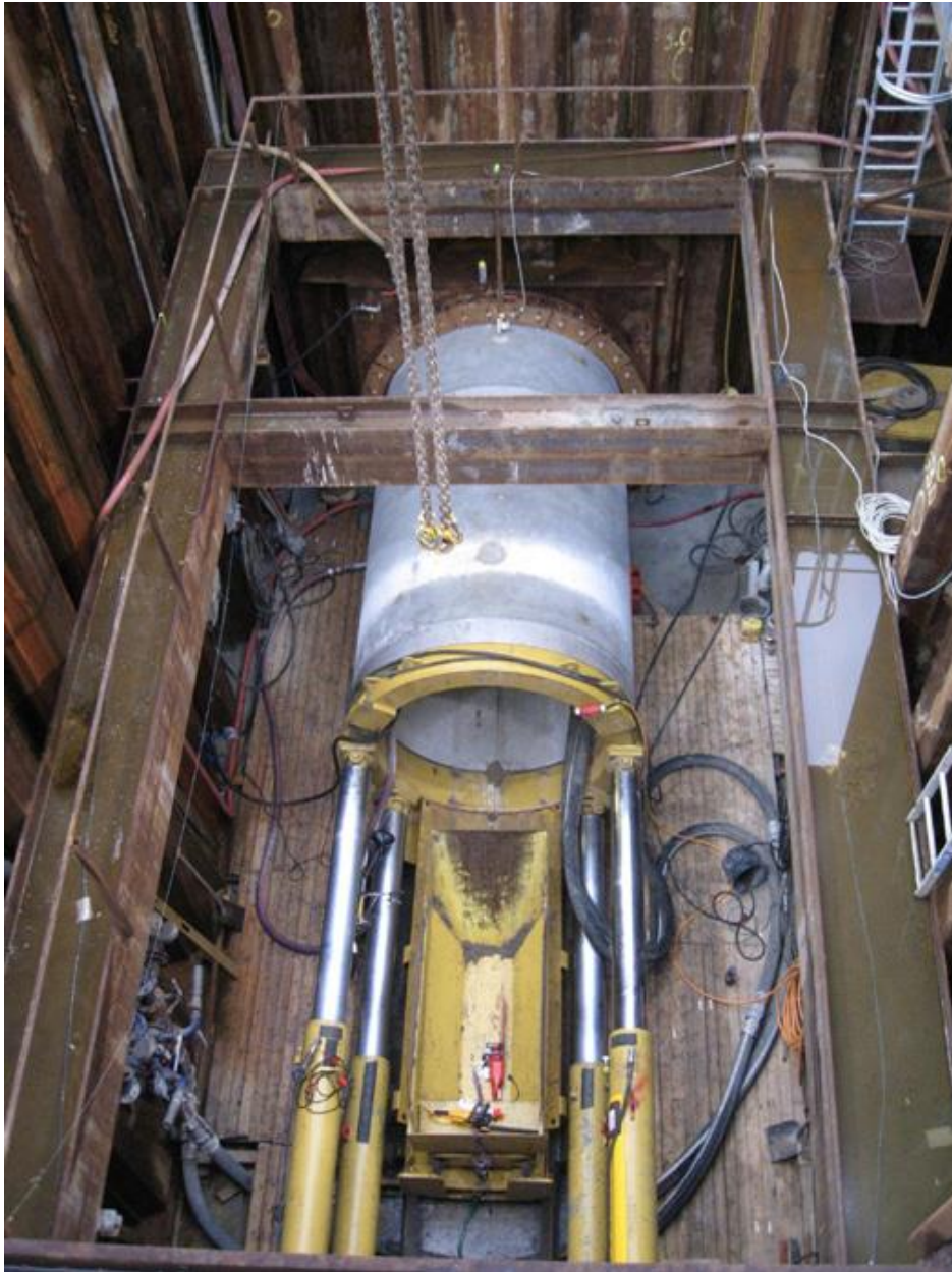
Figur 4 Pressegrøp av spunt sett ovenfra med hydrauliske jekker for pressing. Her presses betongrør med diameter 2 m. (Føyn og Lauritzen, 2014)
