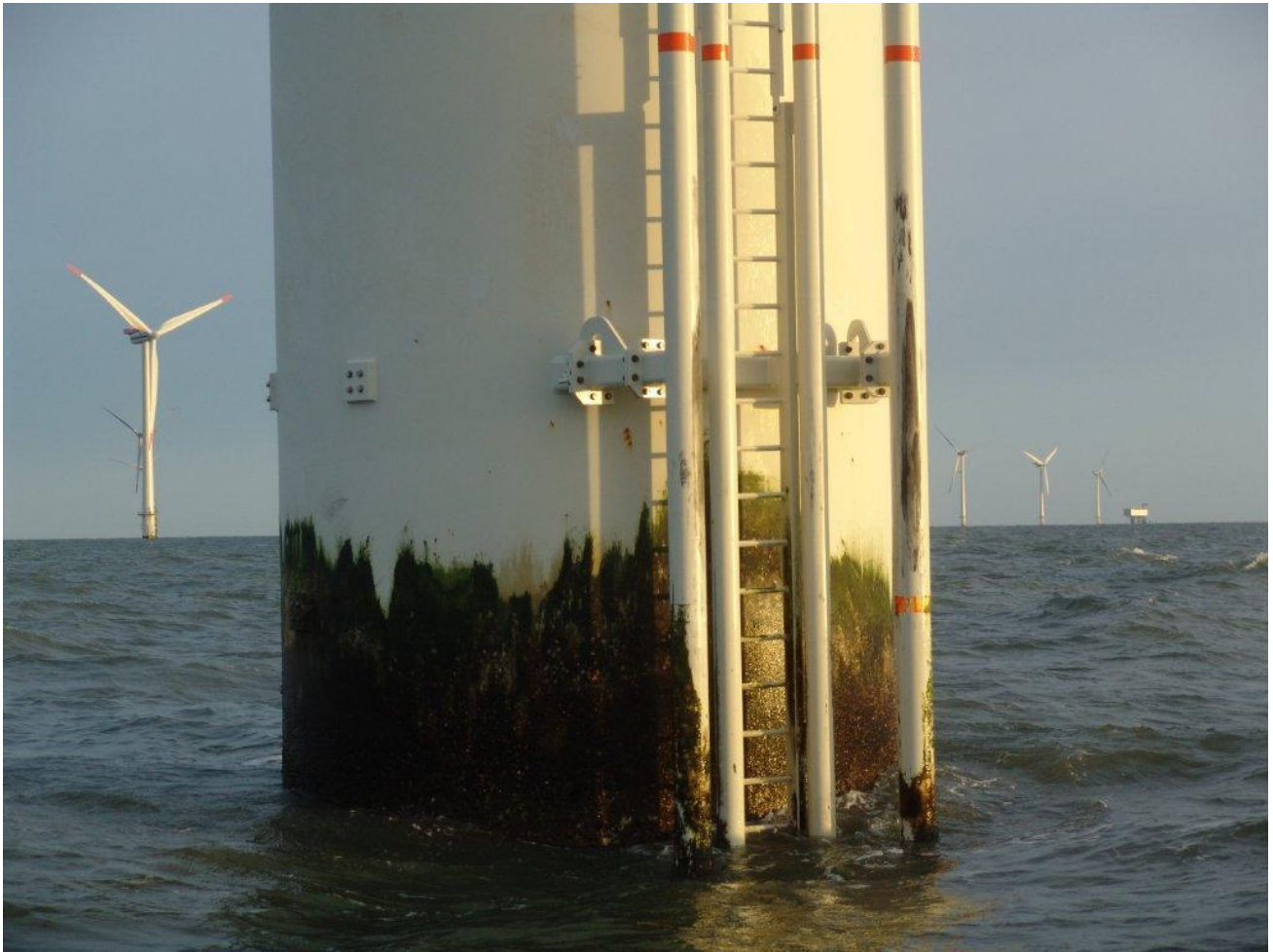
Figur 0.20: Viser fender- rørene på vindturbin hvor slitasjespor fra gummifender oppstår.
