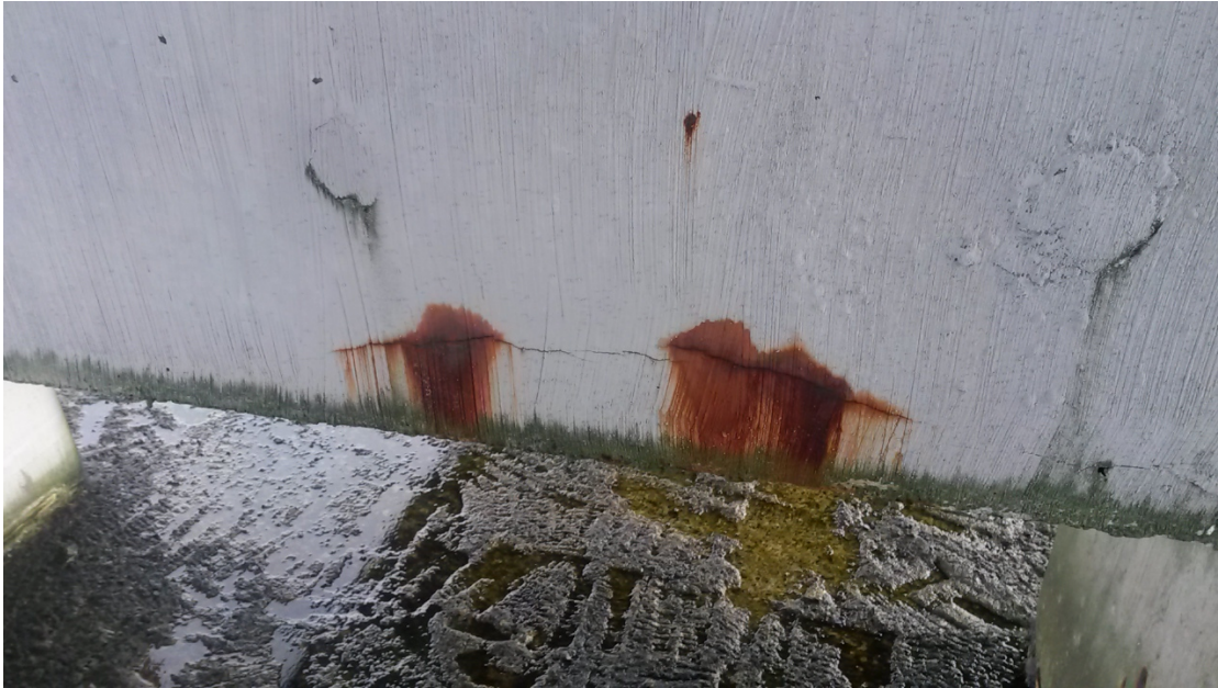
Figur 13.7: Erosjon av overdekning og riss med korrosjon ved landkar
