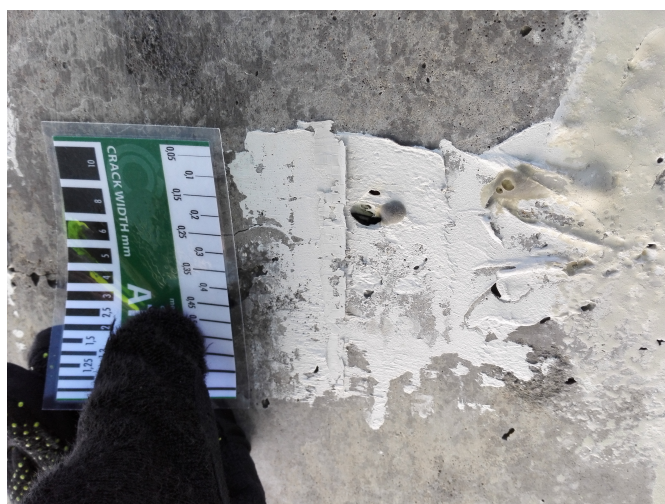
Figur 4.25: Epoxybehandling av riss i UK brubjelke
