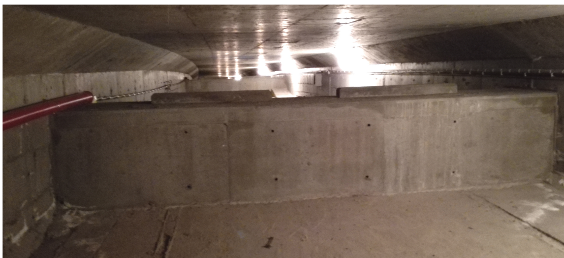
Figur 4.19: Forsterkningstiltak, tverrdrager
