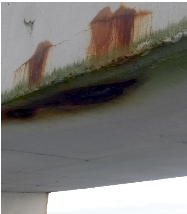
Figur 13.7: Erosjon av overdekning og riss med korrosjon ved landkar
