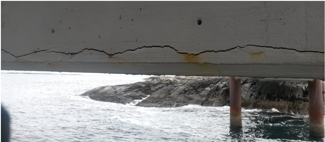
Figur 13.10: Riss i tverrbærer akse 8, w = 5 \text{ mm}
