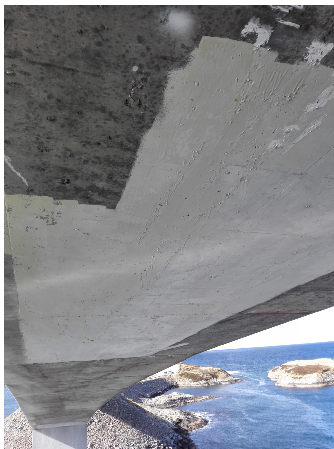
Figur 4.24: Epoxy/sandlag på bruas underside
