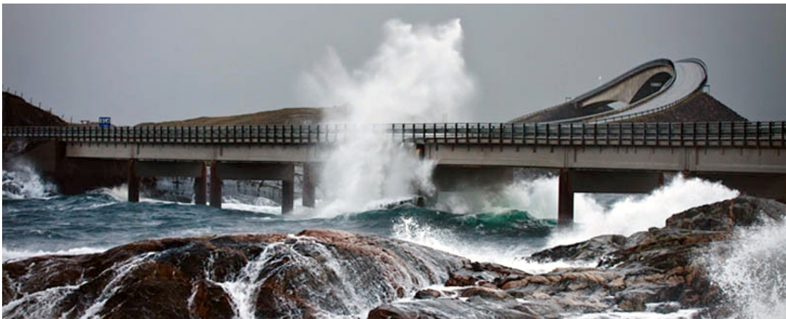
Figur 13.3: Hulvågbrua under en vinterstorm
