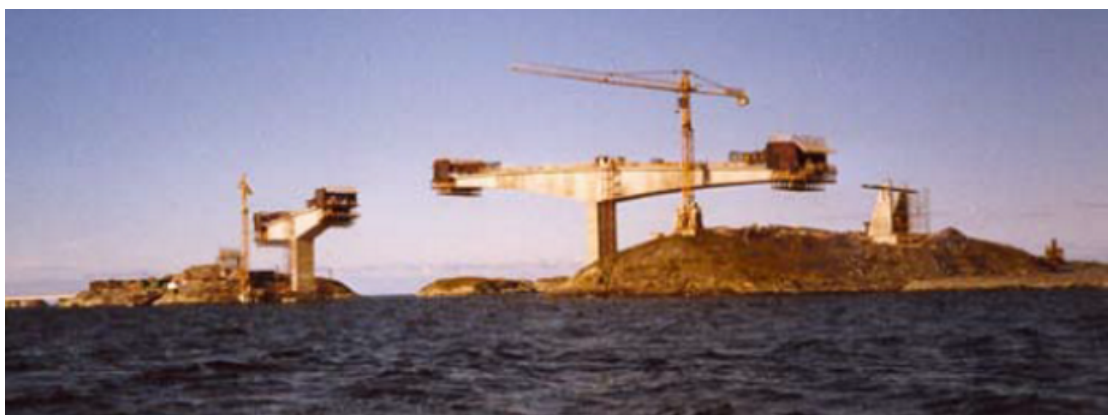
Figur 8.31: Bygging av Storseisundet bru
