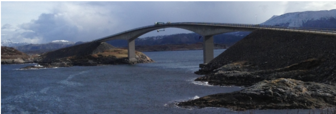
Figur 4.7: Inspeksjon med brulift, Storseisundet bru
