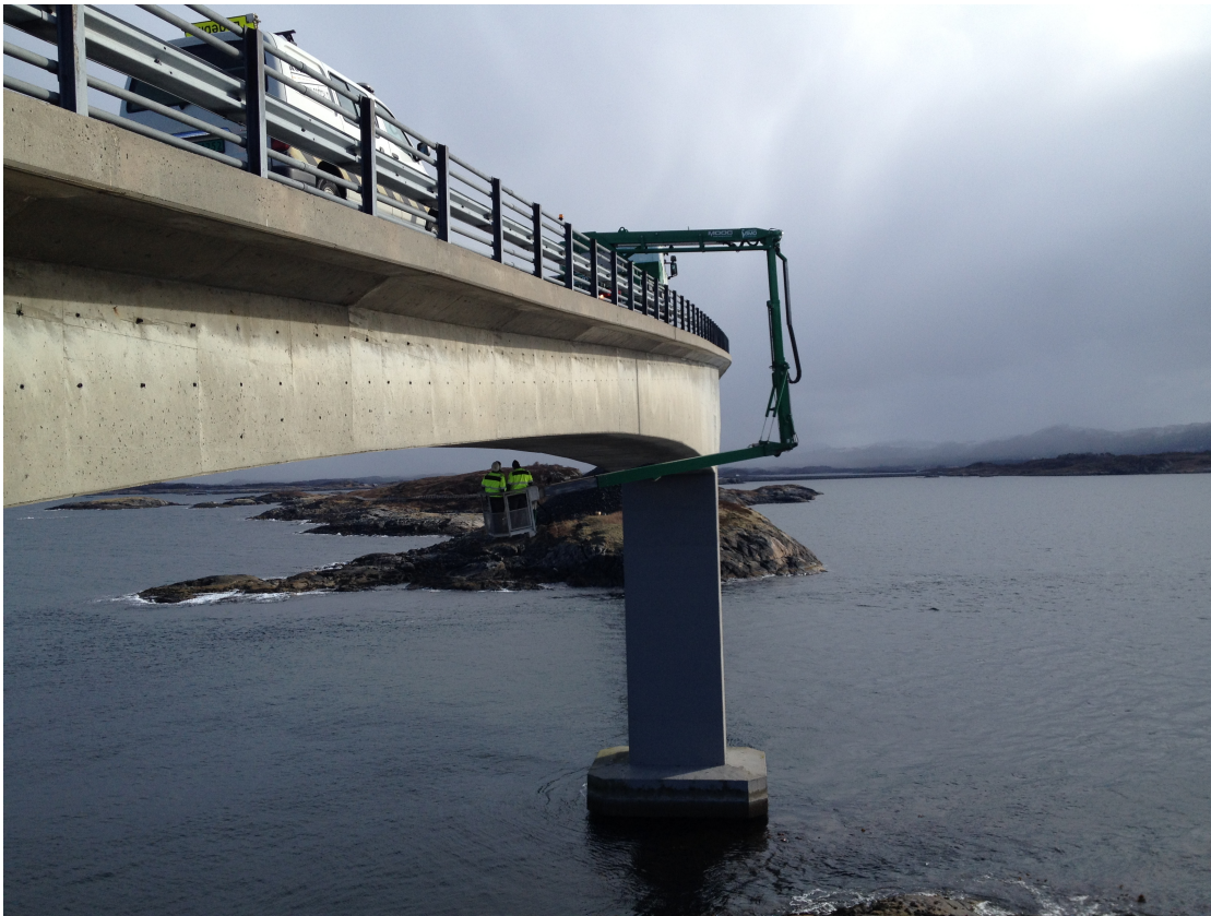
Figur 4.17: Visuell inspeksjon med brulift
