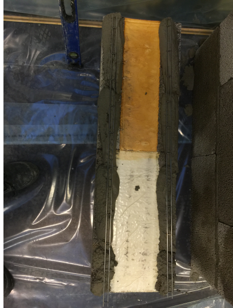
(b) Den ferdig kappede stigearmeringen ble presset ned i mørtelen på hver vange for å gi ordentlig heft.
