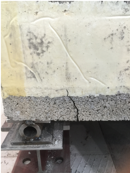
(c) Etter at rissene hadde oppstått ble det en omfordeling av spenninger som forårsaket brudd i strekkvangene.
