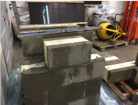
(c) Det ble bygget åtte veggelementer i halvsteinsforband.
