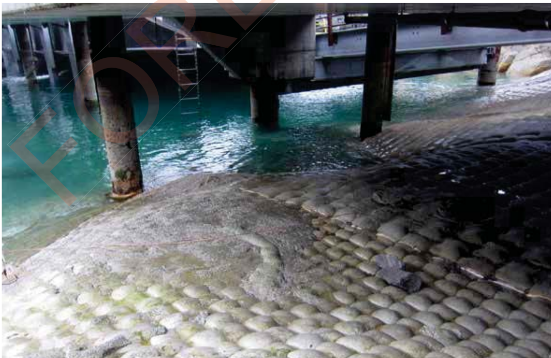
Figur 8-2 Betongmadrass installert under eksisterende tilleggskai og ny ferjekaibru
