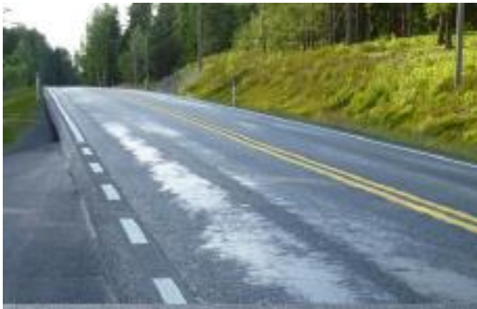
Foto: 6 Blødning i nyasfaltert masse. Foto av: Geir Lange
