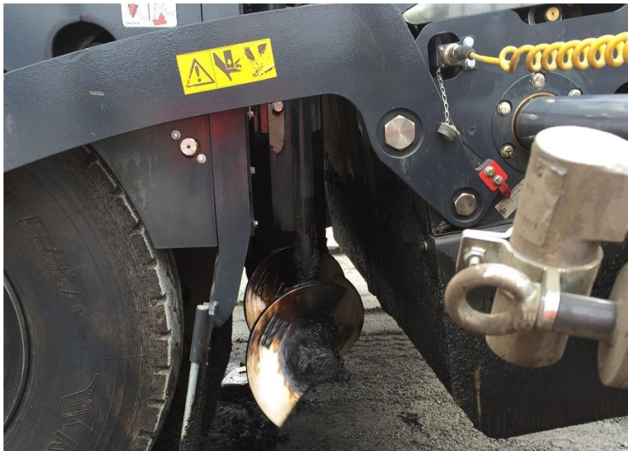
Foto 2: Bildet viser fordelings-skruen på asfaltutleggeren som fordeler asfalten ut i screedbredden. Til høyre for skruen er stampekniver og vibrasjonsplaten som forkomprimerer. Foto: Endre Kobbeltvedt
