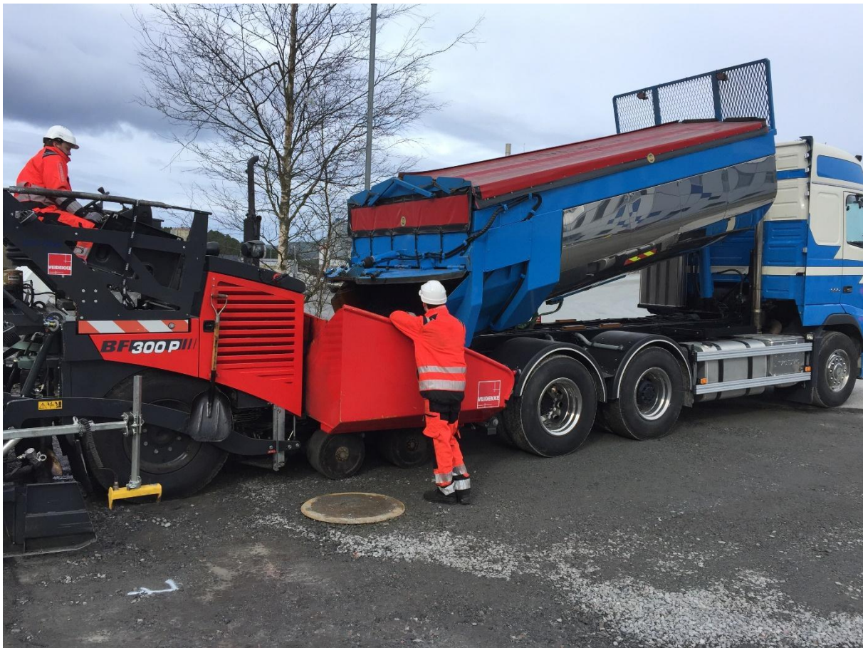
Foto 1: Bildet viser en lastebil som tipper asfalt ned til utleggeren. Foto: Endre Kobbeltvedt
