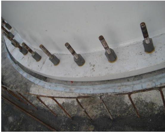
Figur 86 Forbindelse mellom vindmølleturbin, fundament og forankringsstag (93)
