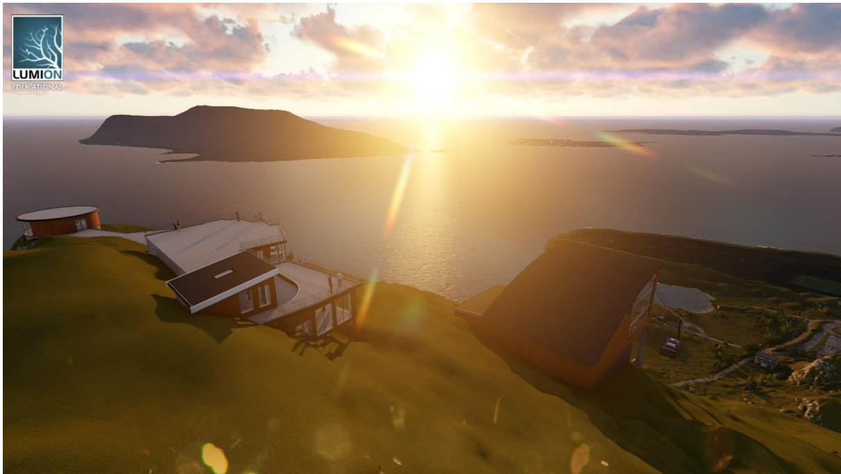
Figur 121 Hovedbygg og toppstasjon i solnedgang.
