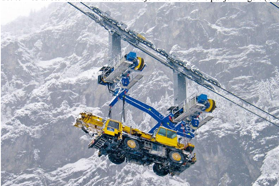
Figur 73 Taubane for frakting av material og utstyr (82)
