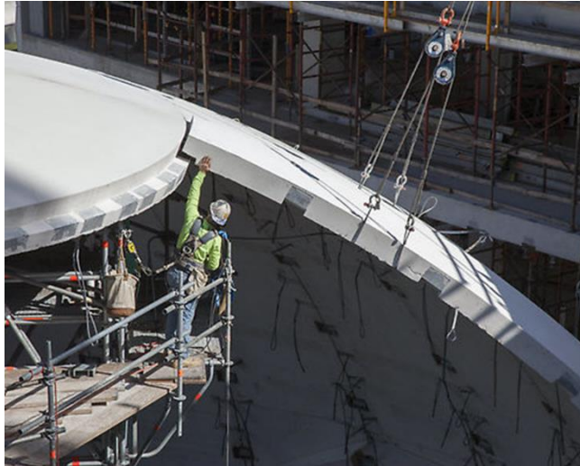
Figur 49: Innstøpte sveiseplater og løfteanordning (66).
