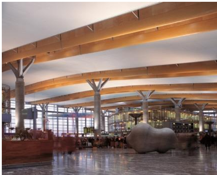
Figur 7: Limtre i avgangshallen på Gardemoen (10)
