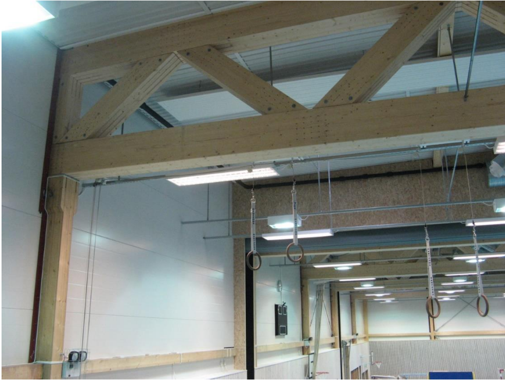
Figur 32: Forbindelser og knutepunkt i limtrekonstruksjon (49)
