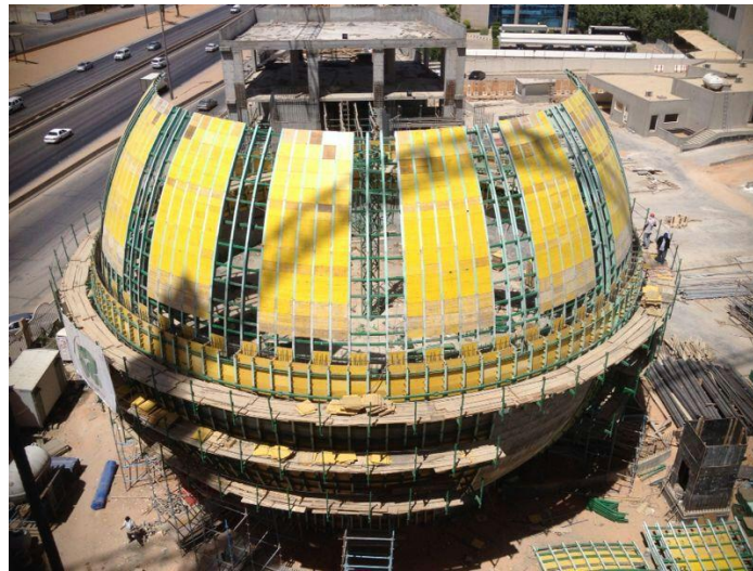
Figur 14: Illustrasjon av forskaling på stedstøpt rund konstruksjon (20)
