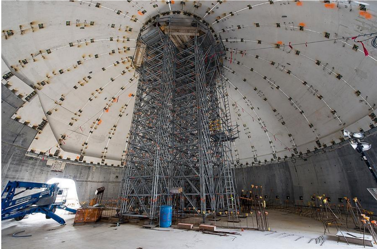
Figur 24: Avstiving ved hjelp av sammensveiste betongelementer (41).
