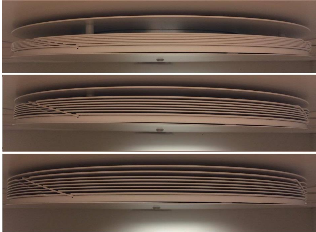
Figur 13 Lindinvent ventil med ulike spaltehøyder (fra øverst: minimal, et sted imellom, maksimal lysåpning).
