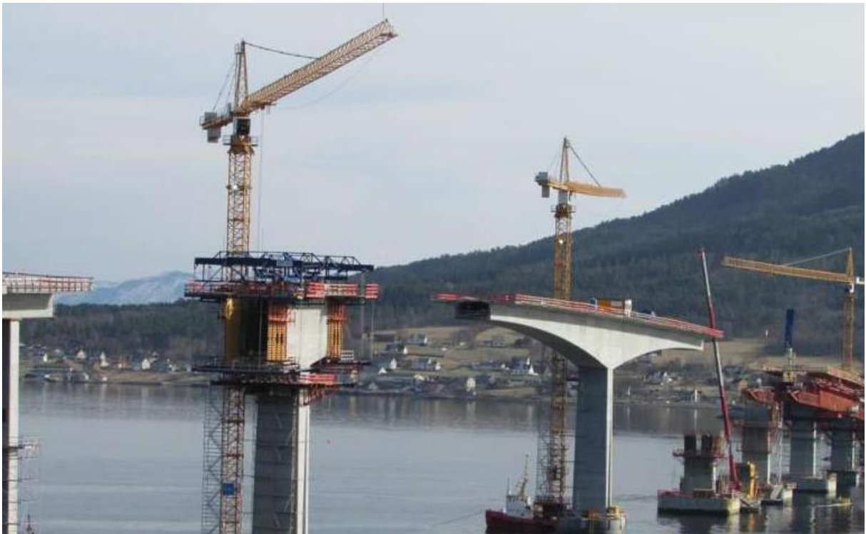
Figur 1: Tresfjordbrua under bygging. Dette er en fritt-rambygg bru (Foto: Statens vegvesen)
