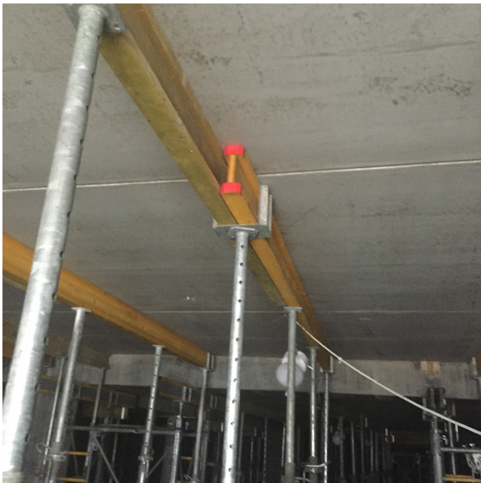
Figur 12: Underside plattendekke med stimpling (privat foto)
