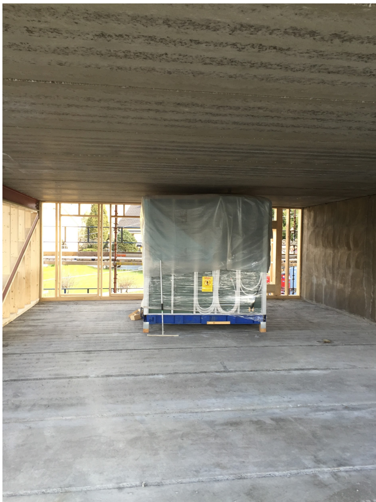
Figur 4: Våtromskabin klargjort for montering (privat foto): NB! Legg også merke til dobbelt svill på yttervegg. Dette pga oppføring/påstøp med trinnlydsplate.
