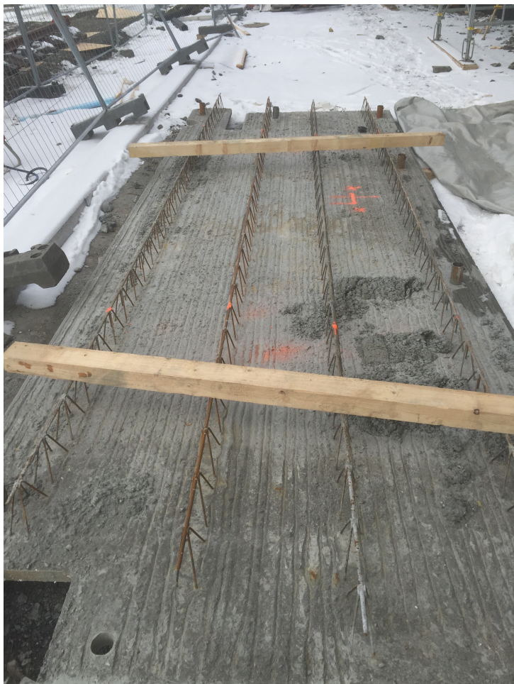
Figur 10: Mellomlagret plattendekke fra Saga Atrium (privat foto): Oversiden er "rå" slik at man får god heft til støp
