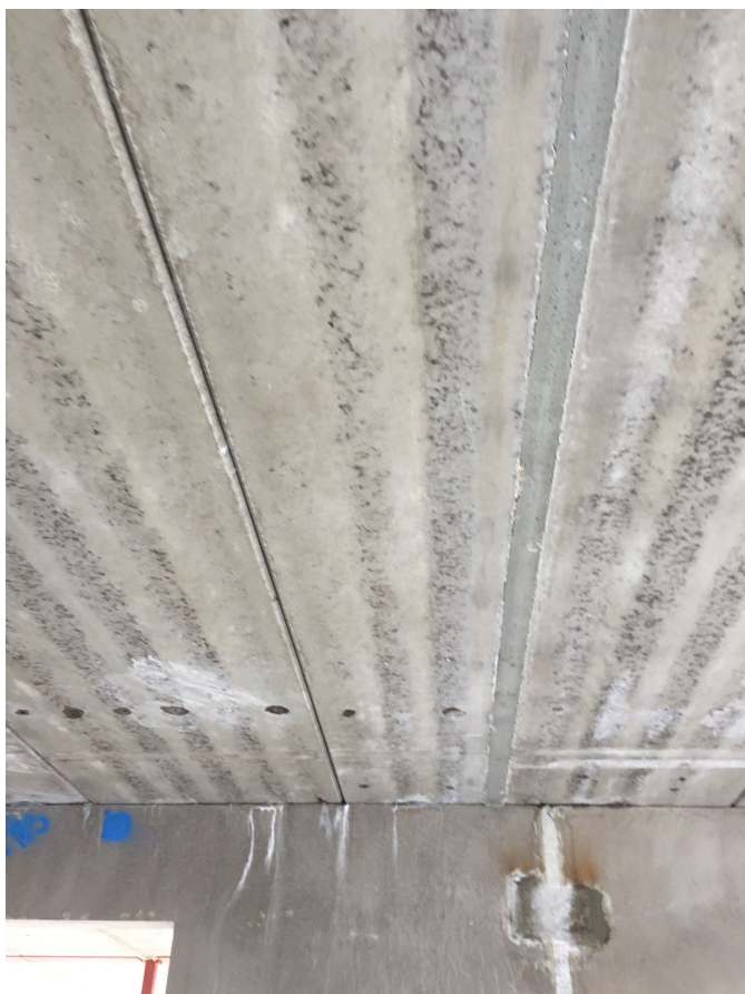
Figur 5: Tilpasningselement med fugestøp (privat foto)
