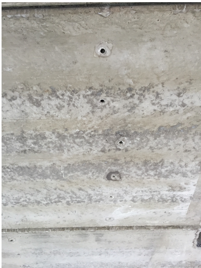
Figur 8: Dreneringshull for hver kanal gjennom hulldekke (privat foto)
