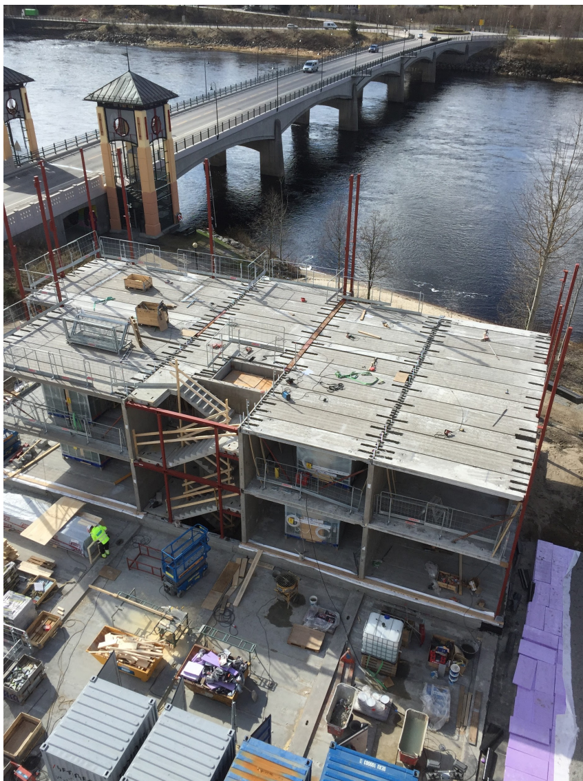
Figur 3: Bæresystemet til en av de 4 blokkene ved Dr Juells Park i Kongsvinger (privat foto)
