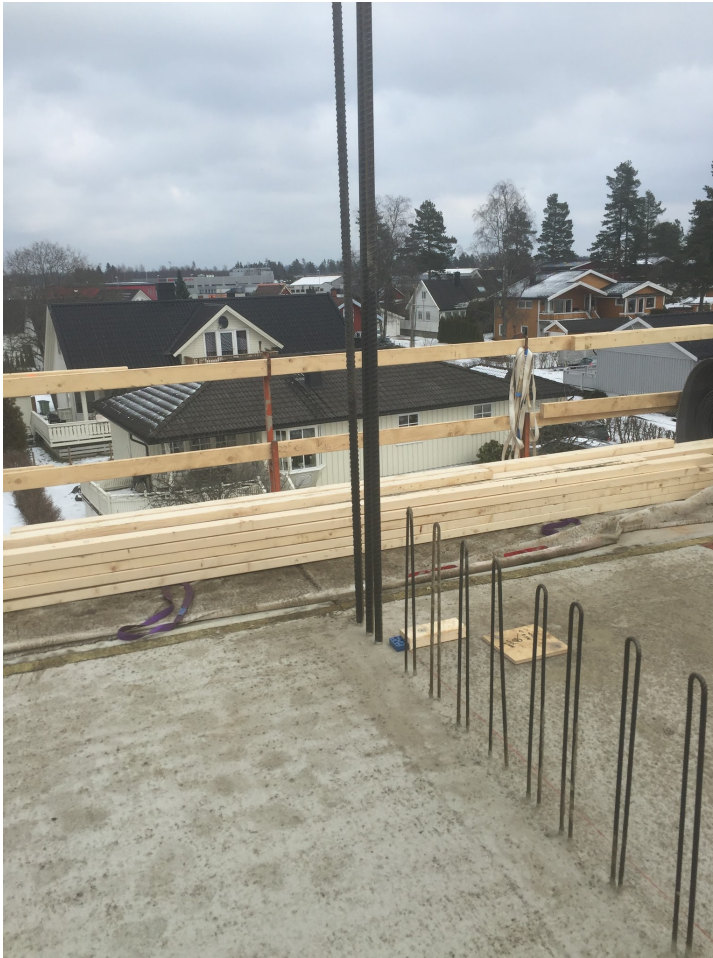
Figur 11: Ferdig støpt plattendecke med skjøtearmering til vegg (privat foto): NB! Man bruker U- jern slik at man ikke skal ha mulighet for "stikkskader"
