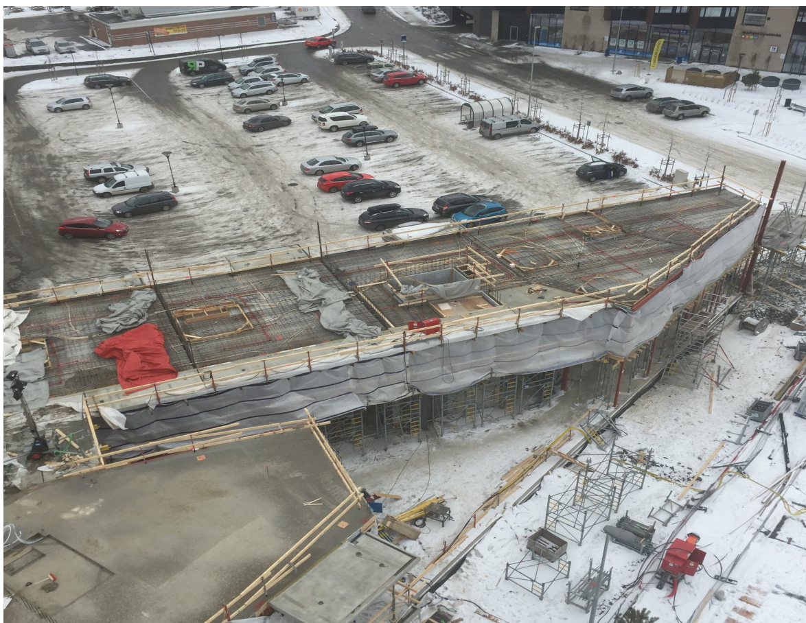
Figur 9: Oversiktsbilde over byggeplassen på Saga Atrium (privat foto): Den øvre delen av bildet er armert i overkant av dekket og forskaling for badrom er under oppføring, i nedre del av bildet er et ferdig støpt plattendekke
