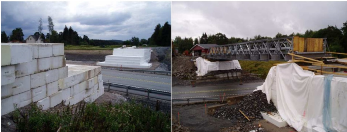
Figur 5.6: Grimsøyveien bru (Aabøe og Frydenlund, 2011)
