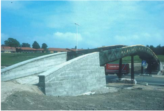
Figur 6.29: Ferdig bygget bru Leie (Aabø og Frydenlund, 2001)
