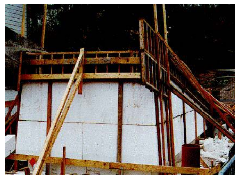
Figur 6.20: Landkar under bygging Skovbøle (Vaslestad m.f, 2014)
