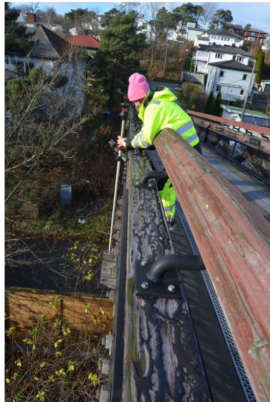
Figur 6.2: Innmåling av bærende
