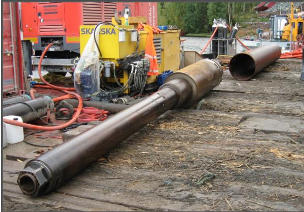
Figur 4-8: RC-borestreng, Gulli bru (Holtmoen 2013)
