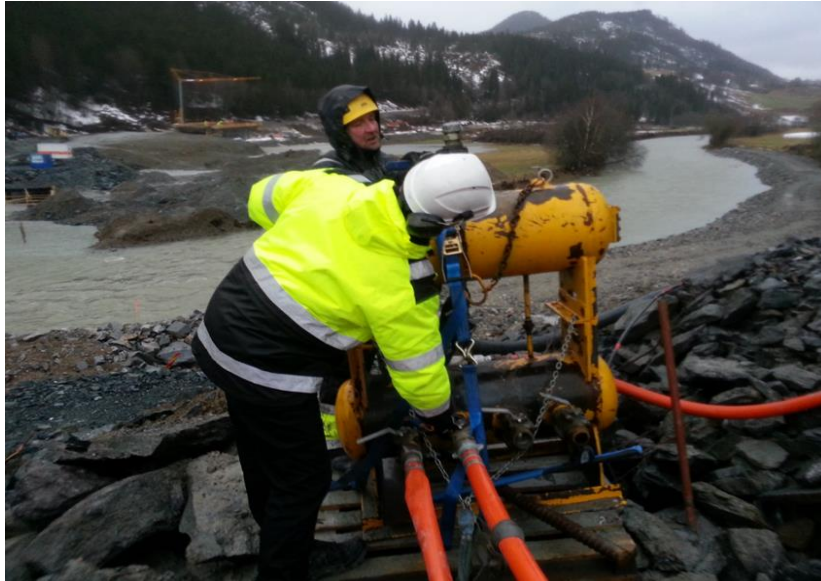
Figur 5-24: Manuell kontroll av vann/luft tilførsel (foto Samson Degago)
