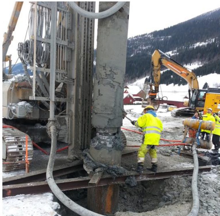
Figur 5-21: Fjerning av klebet masse på borstreng (Foto Henrik Tømmervik)
