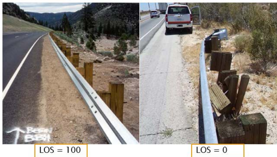
Figur 41. Eksempler på rekkverk med klassifisering av vedlikeholdsstandard [21].
