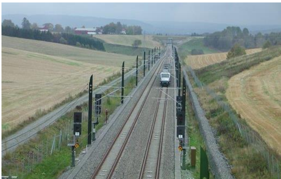
Figur 25 – Gardermobanen ved Venjar. Foto: Njål Svingheim Jernbaneverket 48
