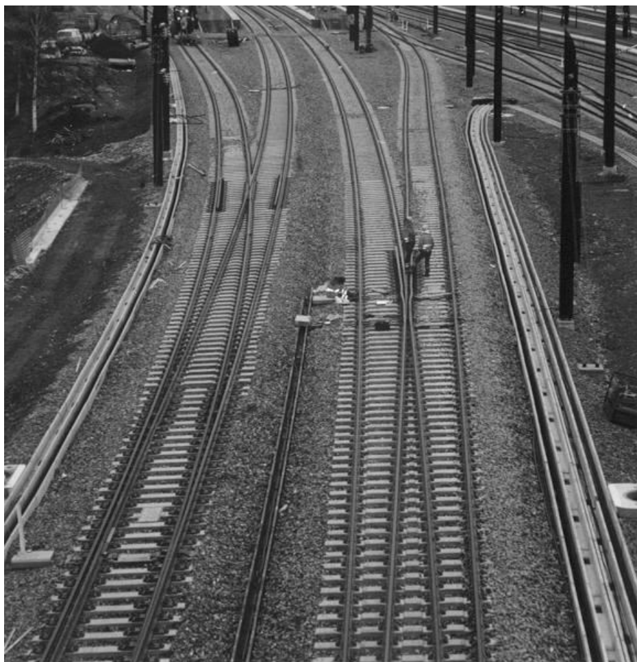
Figur 13 – Klotoidesporveksler på Gardermobanen ved Lillestrøm stasjon 25
