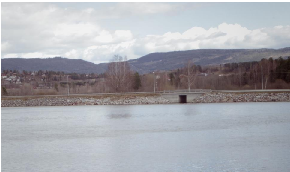
Figur 46 Eksempel på erosjonssikret elvebredde langs Storelva ved Busund. Elvebredden er plastret med stein for å hindre at vannet får direkte kontakt med de mer erosjonsutsatte jordmassene (foto: forfatter).
