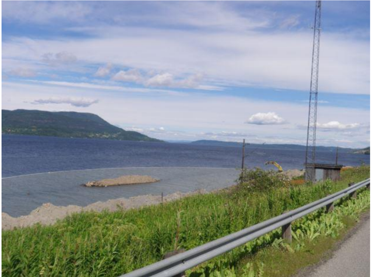
Figur 50 Siltgardin benyttet langs land ved graving i et vei- og baneprosjektet langs Mjøsa. En ser tydelig forskjellen i partikkelinnhold på innsiden og utsiden av siltgardenen. (Systad, 2013)
