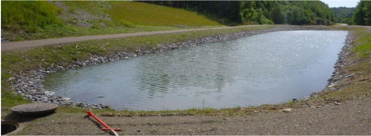
Figur 47 Eksempel på sedimentasjonsbasseng utformet for rensing av veivann.(Åstebøl, 2013)
