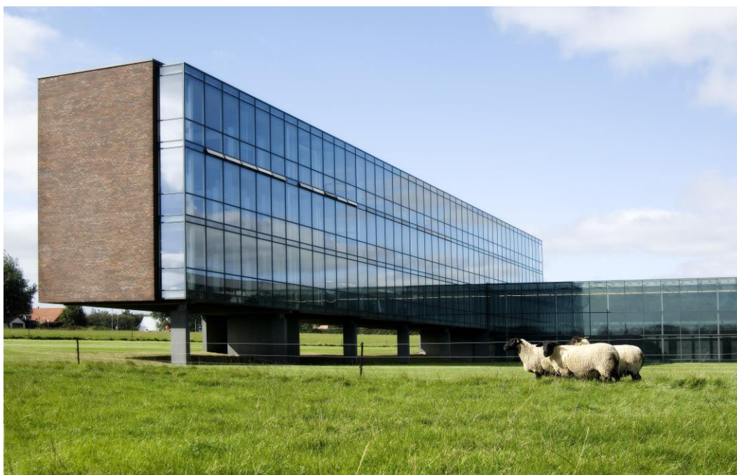
Figur 2.11: B&O hovudkvarter i Danmark. Biletet viser nordfasaden. Brukt med samtykke. Foto: Thomas Juul.
