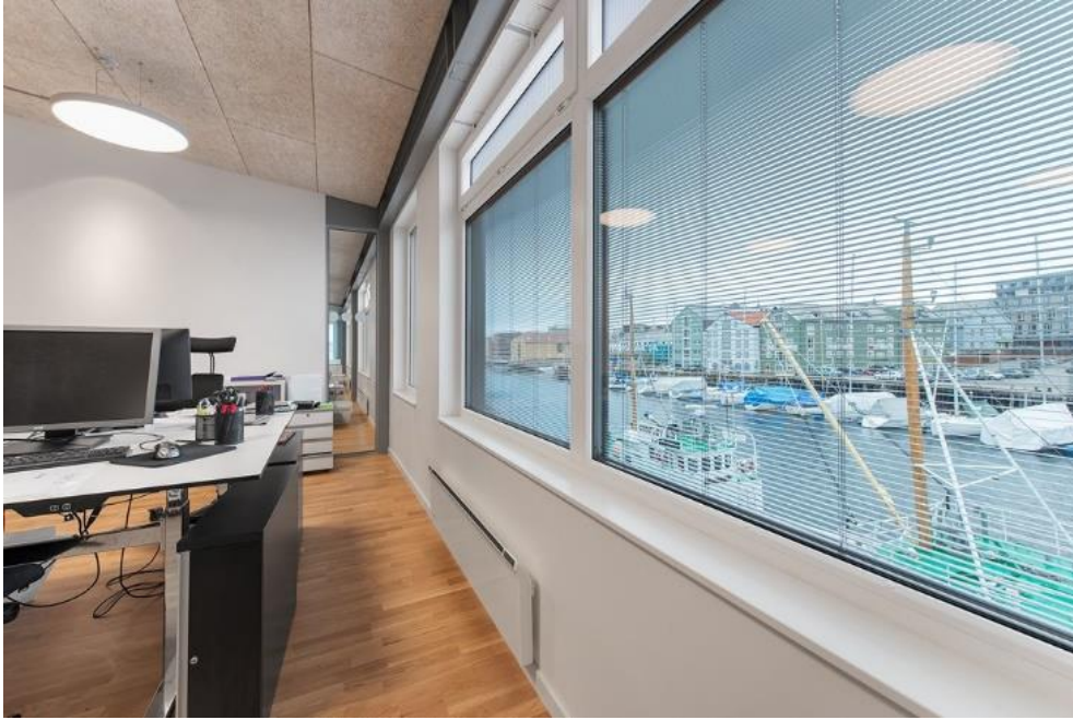
Figur 2.6: Plassering av radiatorar under vindauge hjå ARC Arkitekter. Brukt med samtykke. Foto: ARC Arkitekter (2015)
