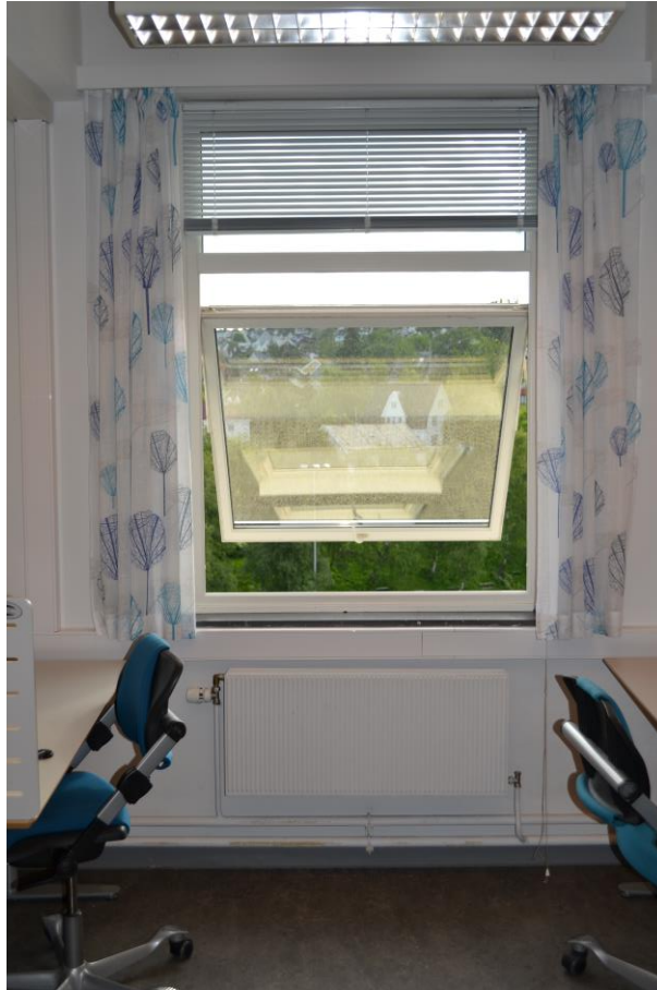
Figur 4.5: Vindaug nummer 4 med opningsareal rundt 0,62 m 2 .
