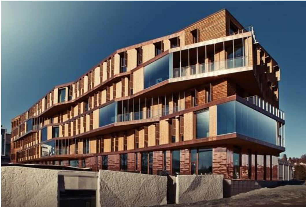
Figur 3.1: Sørfasade på NINA-huset. Brukt med samtykke frå driftsavdelinga ved NINA-huset.
