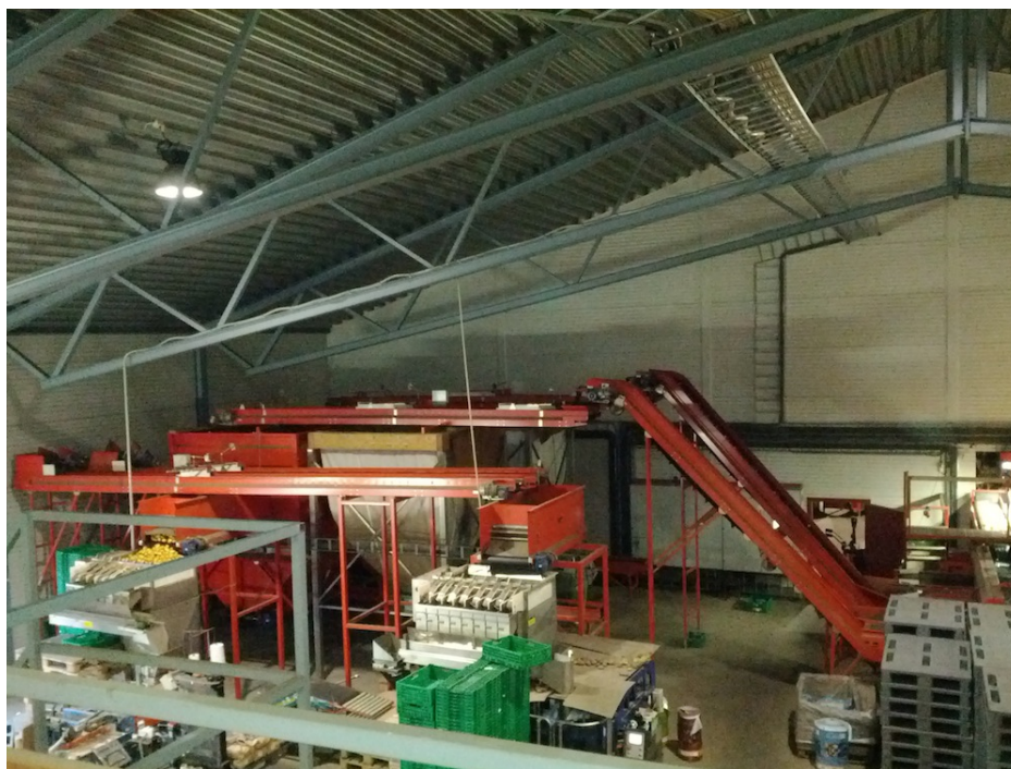
Figur 4.3: Oversiktsbilde over pakkelinjen på Håa
