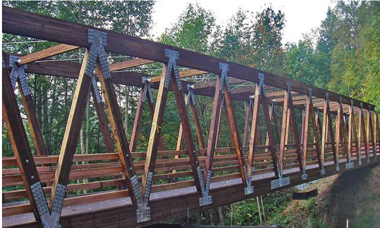
Figur 5. Brokonstruksjon med kryss-struktur (WesternWoodStructures, 2015)
