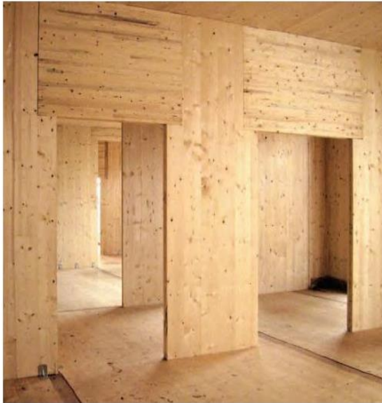
Figur 7. Vegger og dekker av krysslagte massivtreelementer (FPInnovations, 2015)
