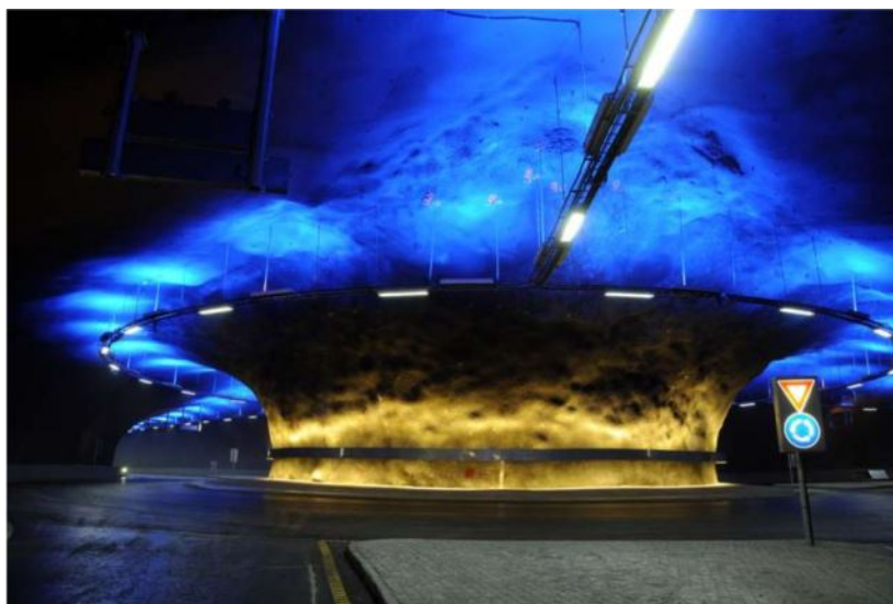
Figur 4.11: Belysning i rundkjøring (bilde fra Karmøy-tunnelen i Rogaland). [35]
