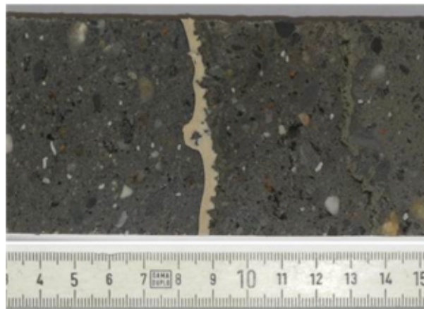
Figur 4 Bilde av sprøytebetong med membran (Holter K. G., 2013)
