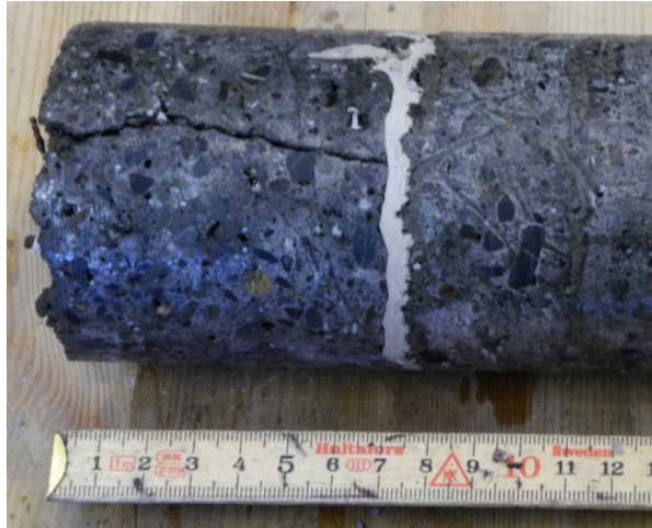
Figur 2 Mikrosprekk grunnet autogen krymping. Foto av en sprøytebetongkjerne med sprøybar membran. Kilde: (Holter og Tandberg, p.p., WTC2014)
