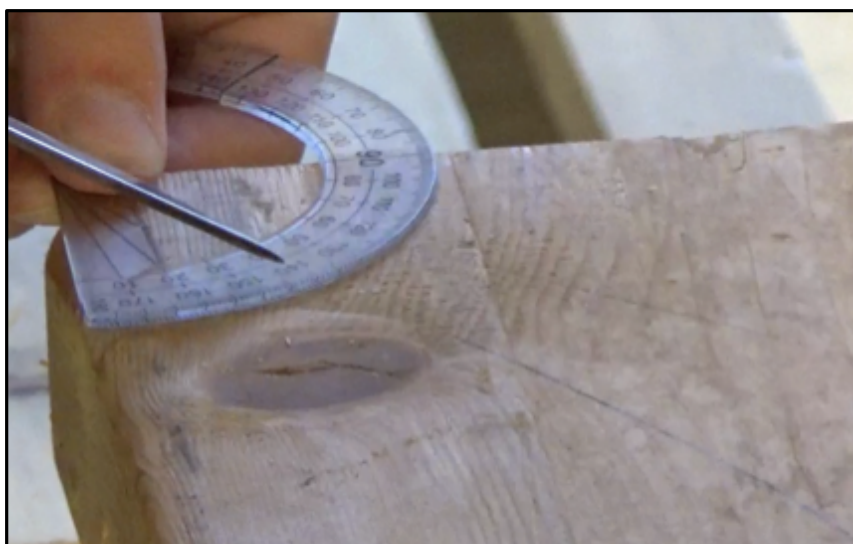
Figur 5.18: Tore skrår taksperren ved hjelp av gradskive.
