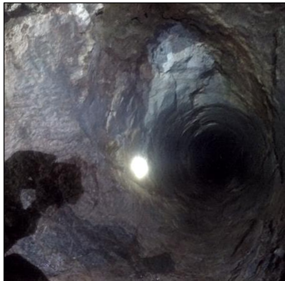
Figur 10. Bilde viser profil 134m etter rensk. Fagarbeider måler maks høyde til 2,4 m i det utrenskede partiet. Foto: Implenia.
