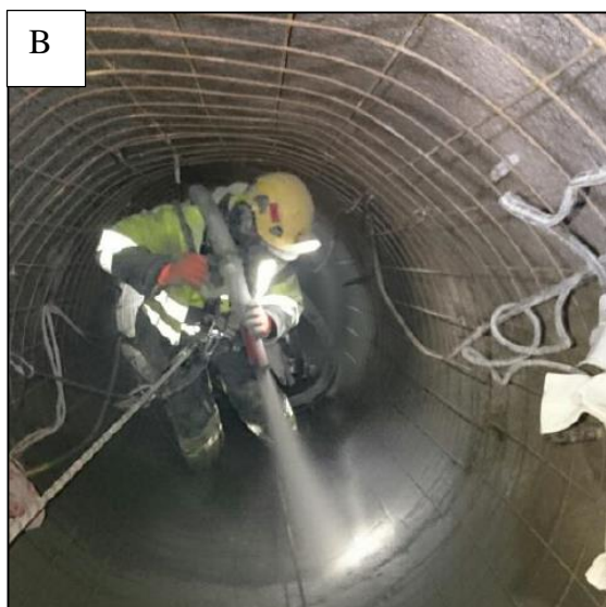
Figur 14. Bilde A: brudd på slangen som førte sprøytebetong oppover i sjakta var et stort problem under arbeidet. Bilde A og B viser henholdsvis klaterer fra Implenia som påfører sprøytebetong og henger opp og tilpasser armeringsnett i sjakta. Foto: Implenia.
