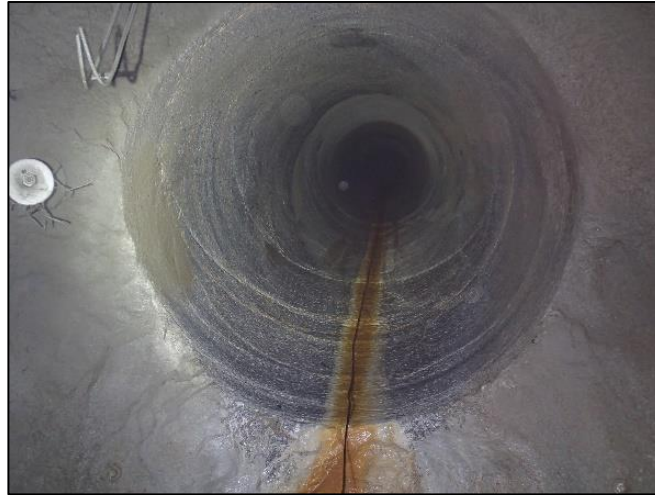
Figur 53. Bildet er tatt mot sjakta fra trykktunnelen. Foto: Rune Fagerheim.
