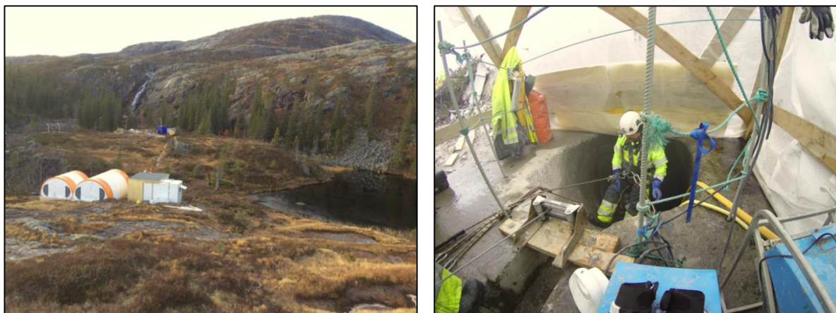
Figur 4: Til venstre: Anleggsområdet oppe i fjellet (Arnfløgen). Til høyre: rigg ved inntak til sjakta. Vaiersving til vogn og tauanker til klatretau vises. Foto: Implenia
