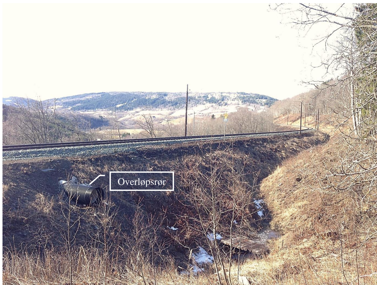
Figur 6.2 Bildet er tatt fra bunnen av skråningen og viser overløpsrøret som er lagt inn med formål om å begrense konsekvensene av et eventuelt skred i overliggende terreng. Foto: Hilde D. Jordet, 11.04.16
