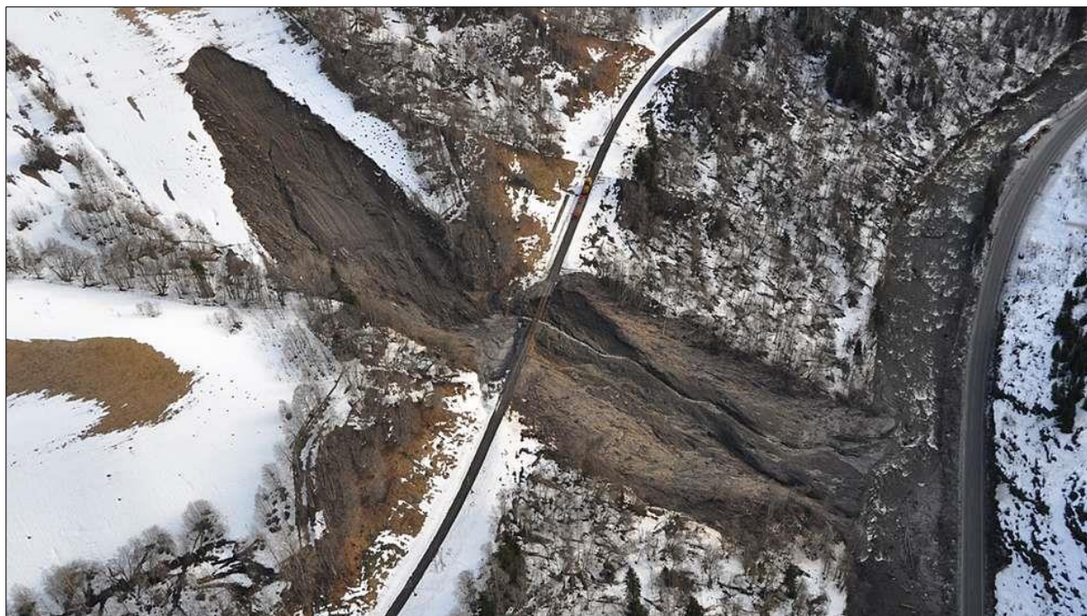
Figur 1.2 Skredet 13. og 14.03.12 sett ovenfra (Skybakmoen, 2012).
