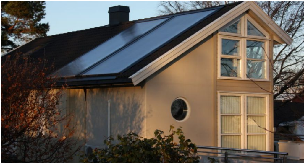
Figur 3. Solfangere integrert i tak. Kilde: www.asvsolar.no/
